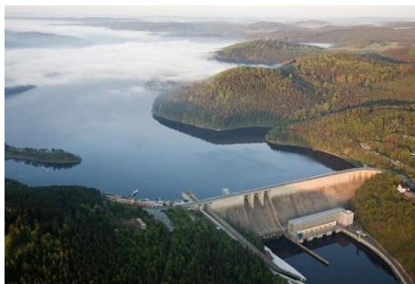
Obrázek 4: Akumulační elektrárna Orlík
