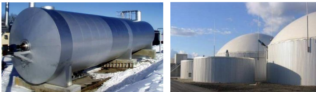
Obrázek 6: Ukázka horizontálního reaktoru (vlevo) a vertikálního reaktoru (vpravo). Zdroj [7]
