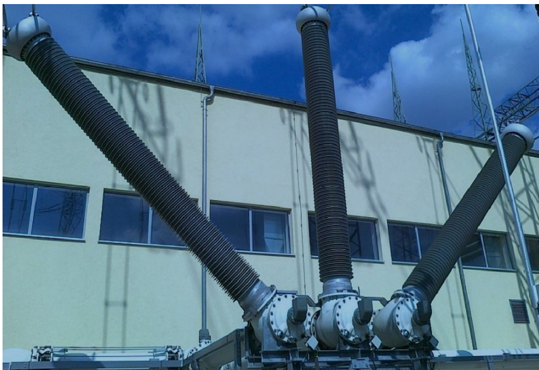
Obr. 5.9 Venkovní průchodka zapouzdřené rozvodny [20]
