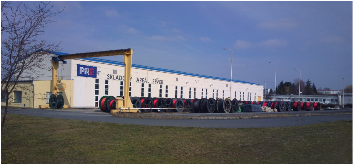
Obr. 5.8 Pohled na dnešní stav v místě budoucí rozvodny Praha-sever 420 kV
