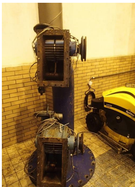
Obr. 4 Vymontované původní Bánkiho turbíny
