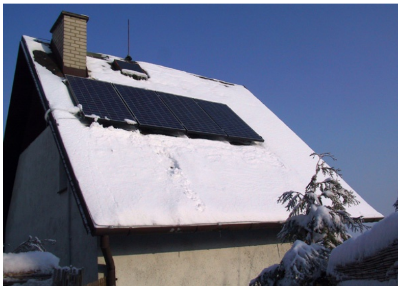
Obrázek 25: Sníh z FV panelů obvykle sjede krátce po osvětlení sluncem. [43]
