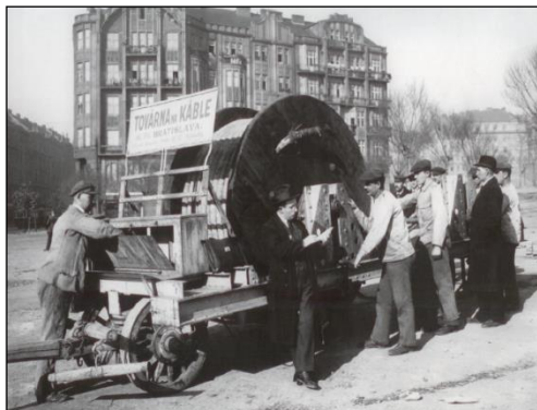
Obrázek 1: Pokládka kabelu ve Vršovicích 20. léta 20. století
