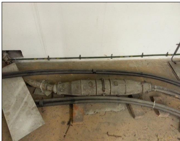
Obrázek 11: Kabelová spojka 22 SVN Kablo Kladno
