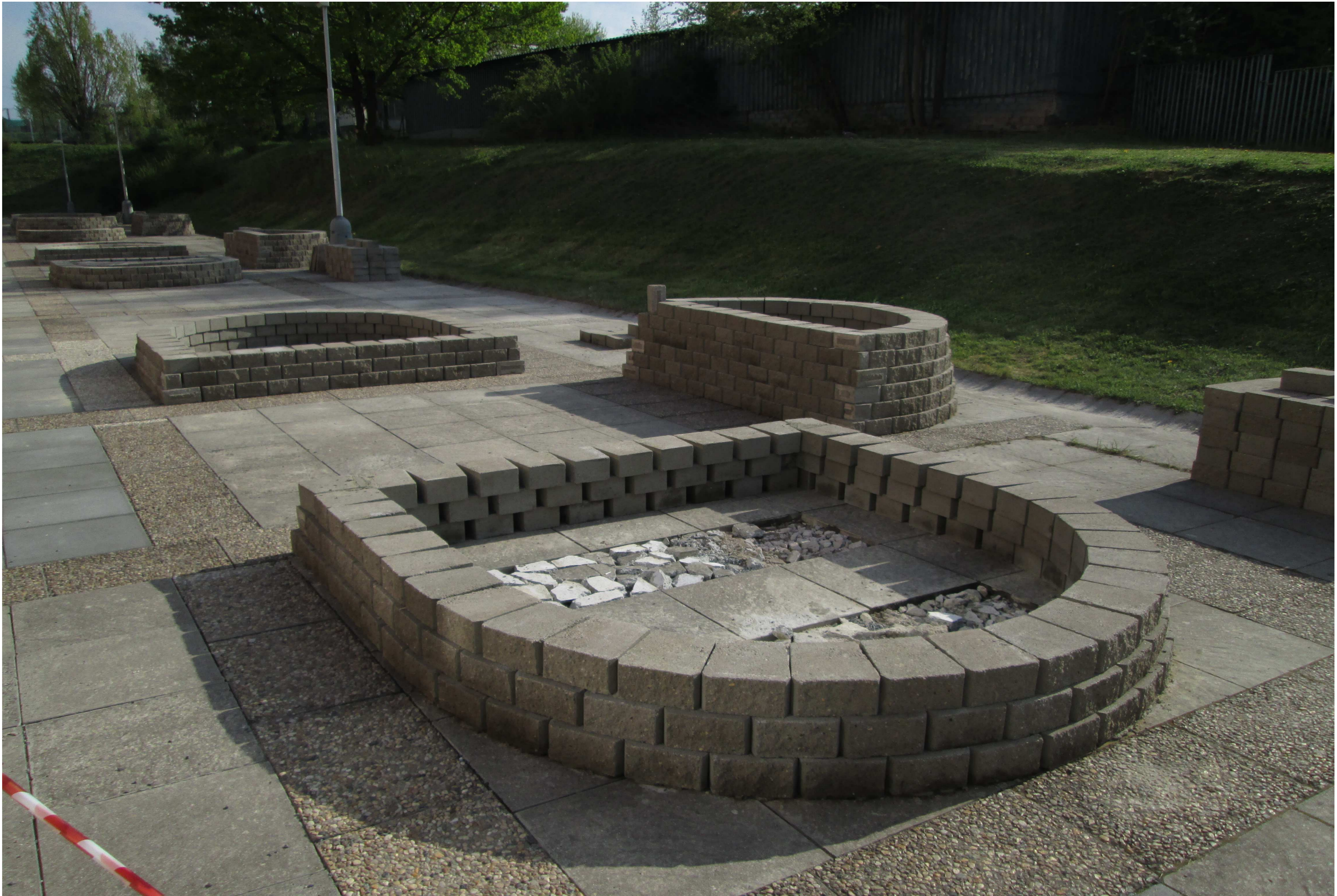
Obrázek 4 - výstava firmy KB - BLOK systém, s.r.o. - v průběhu realizace
