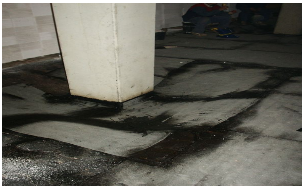
fotografie č.1, 2 – živičné hydroizolační systémy – vodorovná hydroizolace, penetrační nátěr, svařování propan-butanem
