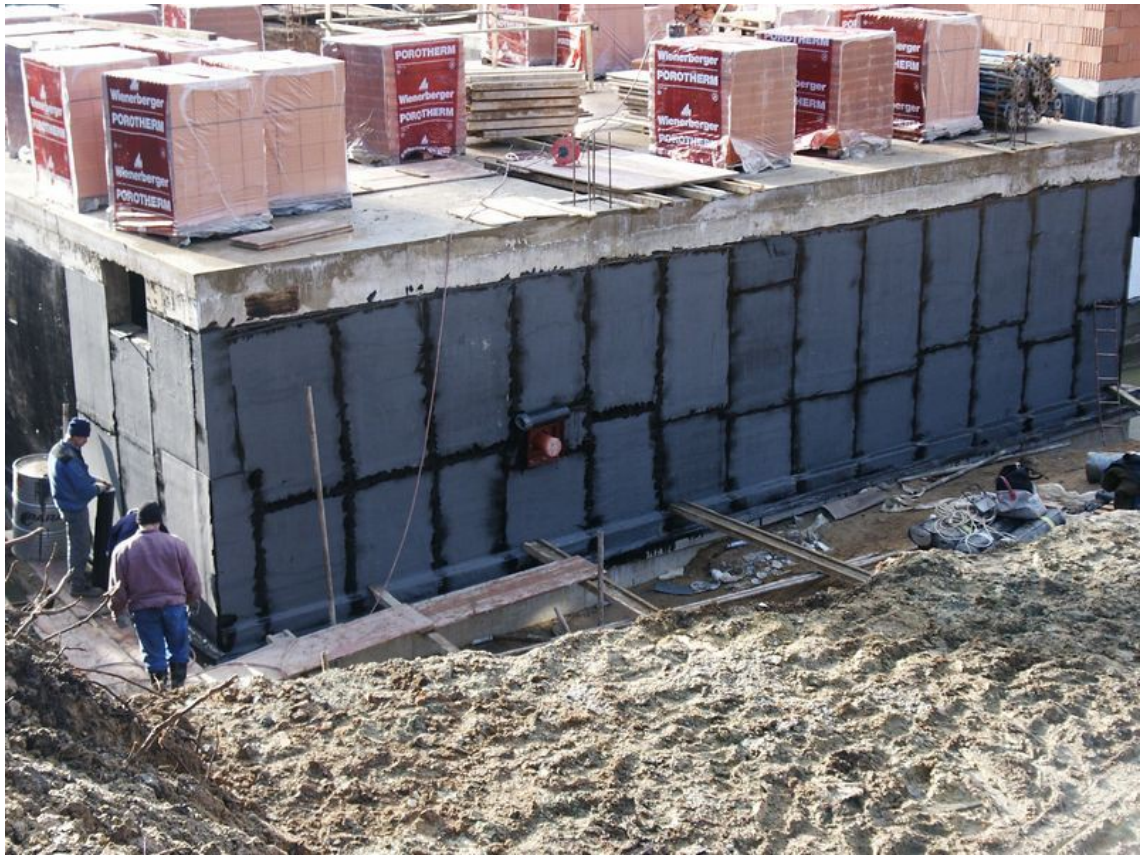
fotografie č.3 – živičné hydroizolační systémy – svislá hydroizolace, penetrační nátěr, svařování propan-butanem
