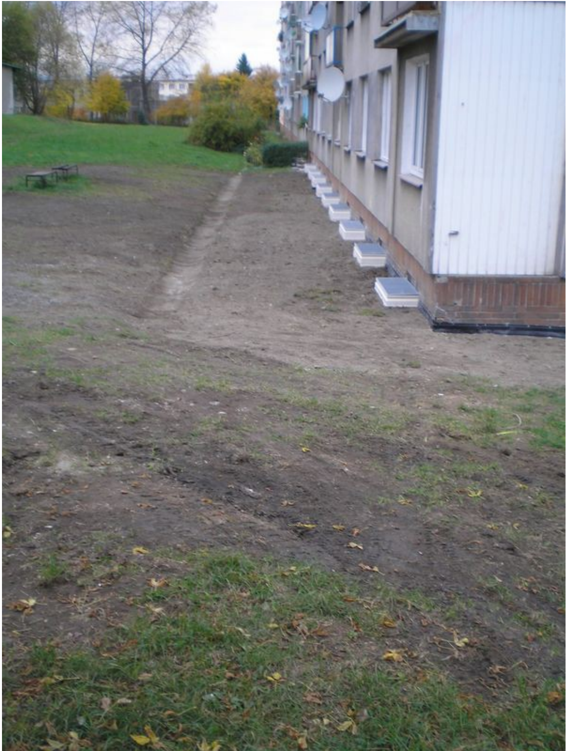
fotografie č. 8 - stav budovy po opravě
