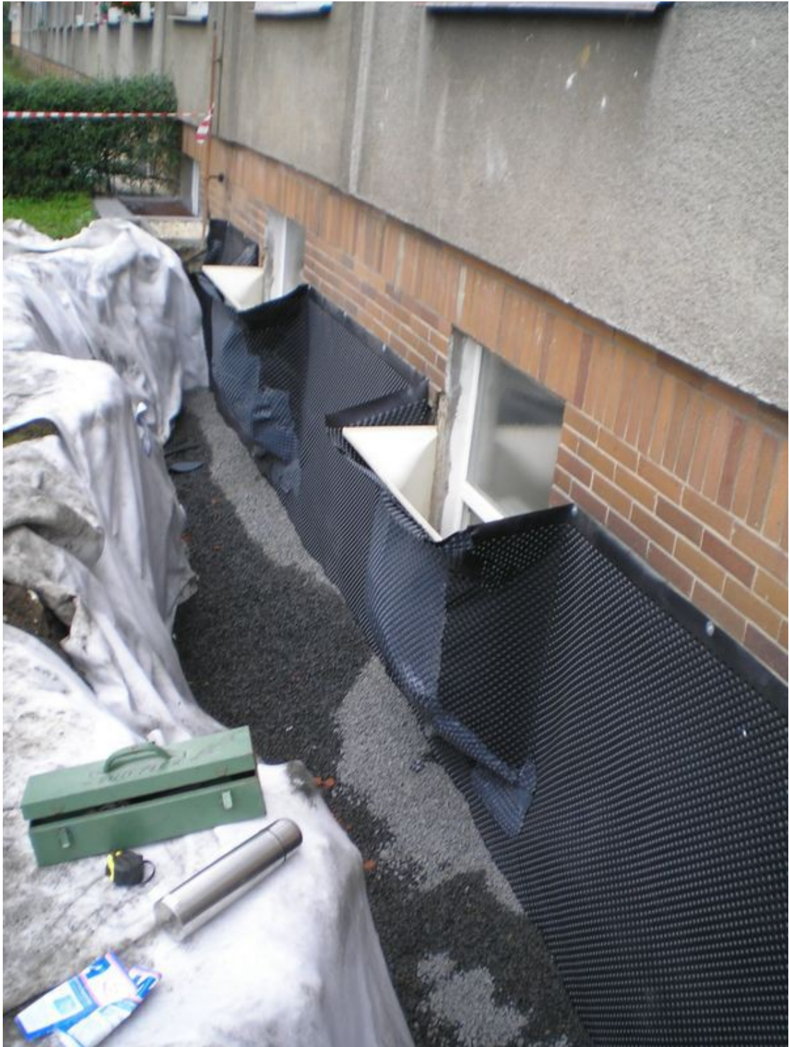
fotografie č. 7 – nopová izolace + geotextilie – svislá hydroizolace text viz výše
