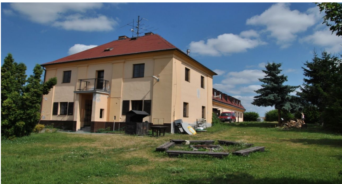
Obr. 15 Historická část objektu
