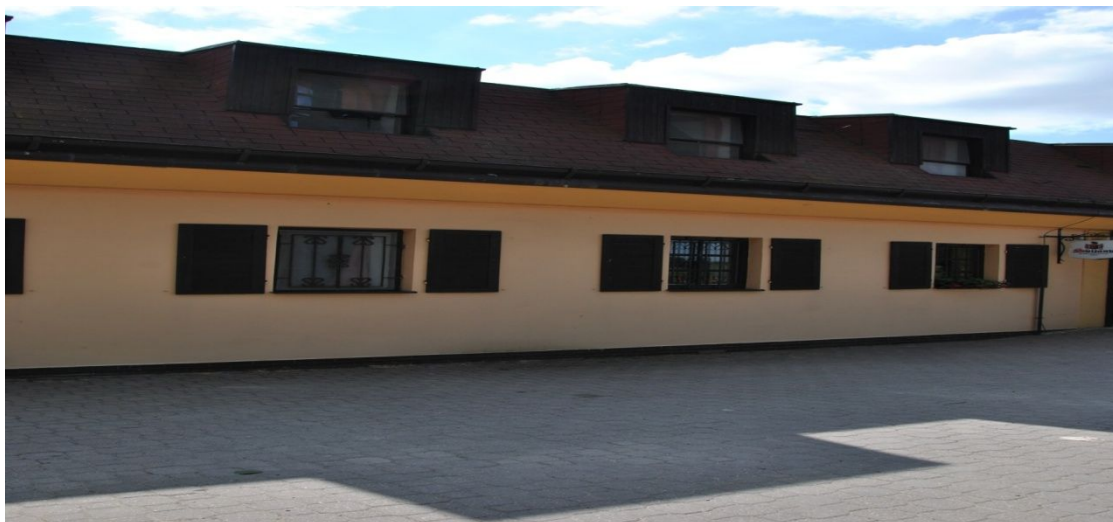
Obr. 16 Střecha a okna objektu
