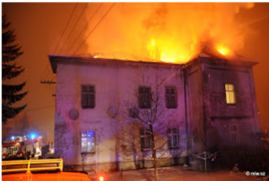
Obrázek 1. Požár bytového domu v Krásné Lípě
