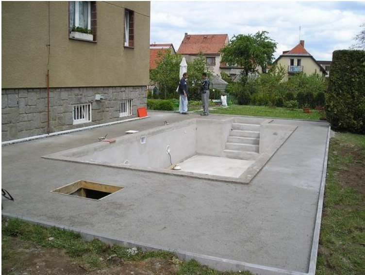
Obrázek 44 – Betonáž desky pod dlažbou
