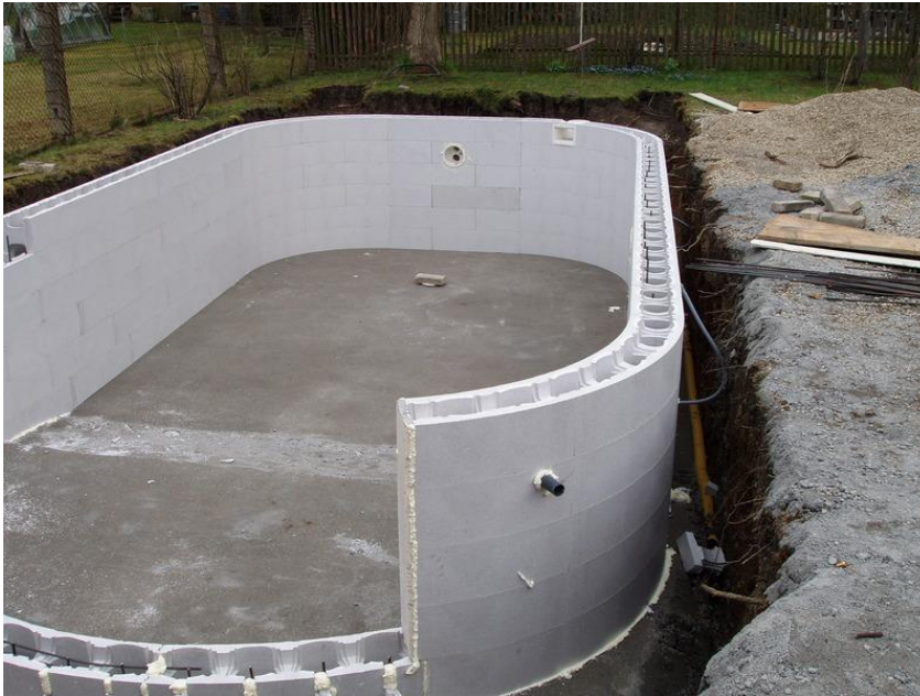
Obrázek 8 - Bazén z termo-bloků
