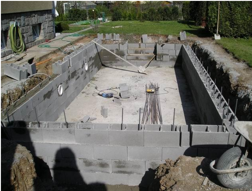
Obrázek 43 - Betonáž betonového bazénu
