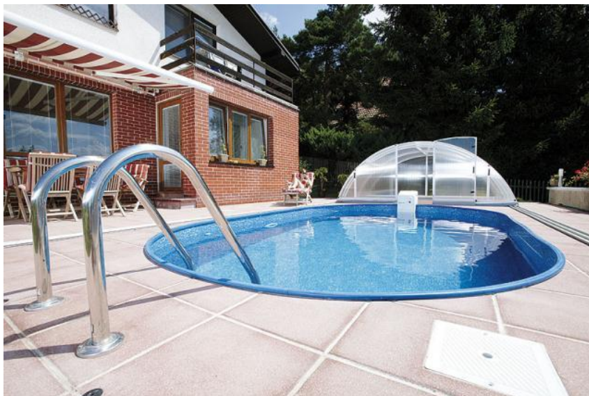
Obrázek 3 - Zapuštěný fóliový bazén s pevnou stěnou
