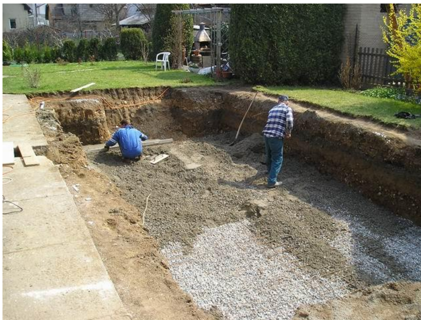
Obrázek 42 – Vyrovnané dno s kari sítí – betonáž dna
