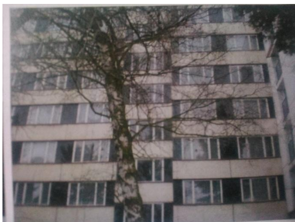
Obrázek 19 Panelový dům před zateplením [25]
