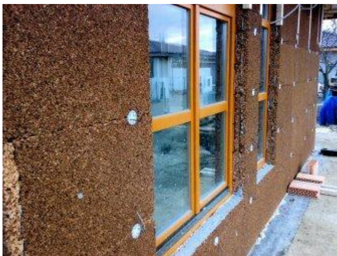
Obrázek 11 Kontaktní zateplovací systém při použití korkové izolace [14]
