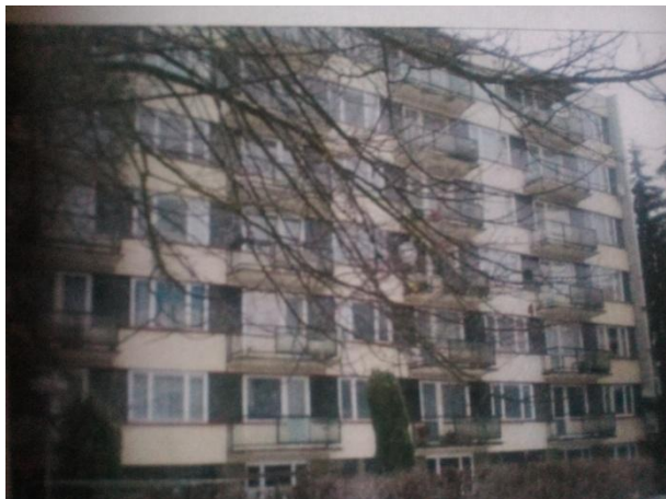
Obrázek 18 Panelový dům před zateplením [25]
