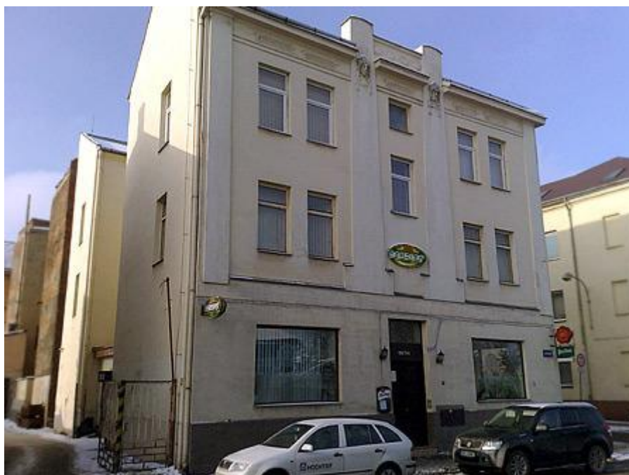
Obrázek 11: Hotel Zlatá Cihla, 4. srovnávaná nemovitost 32
