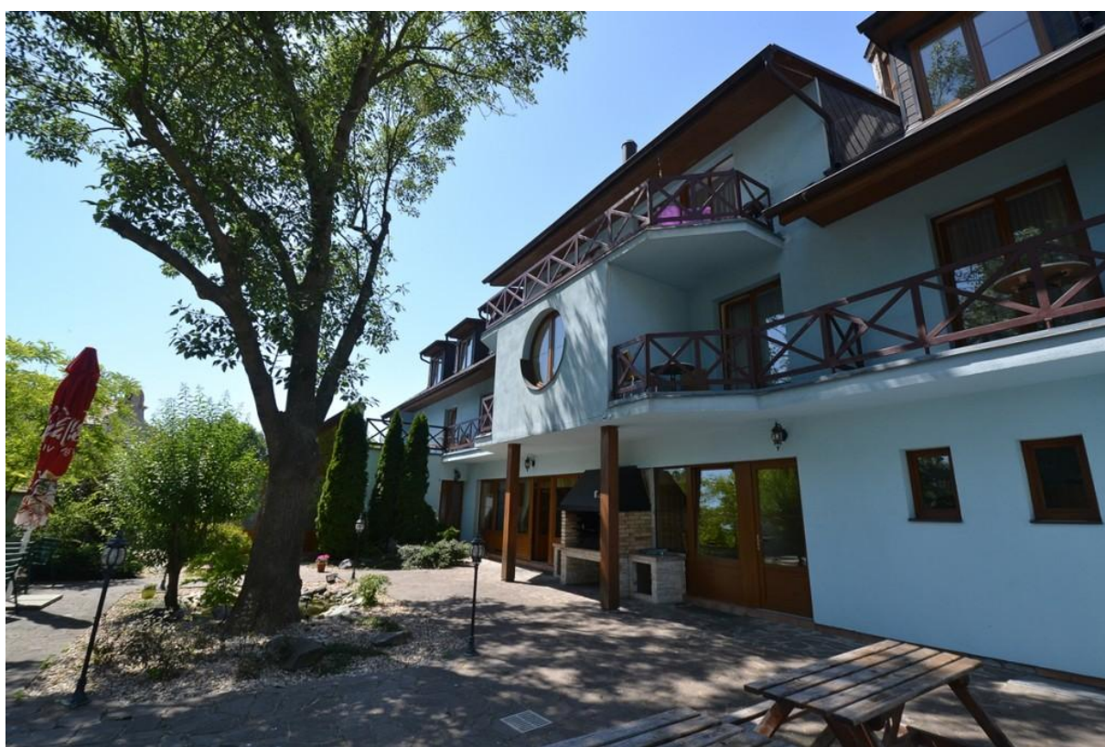
Obrázek 7: Penzion Skalice, 4. srovnávaná nemovitost 21
