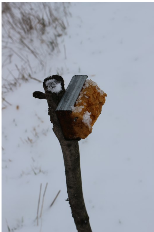
Pachový ohradník na silnici I/12 – pravděpodobně neudržovaný.
