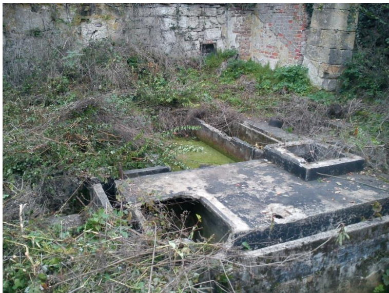
Obr. 4.23 – Místo bývalého čerpadla
