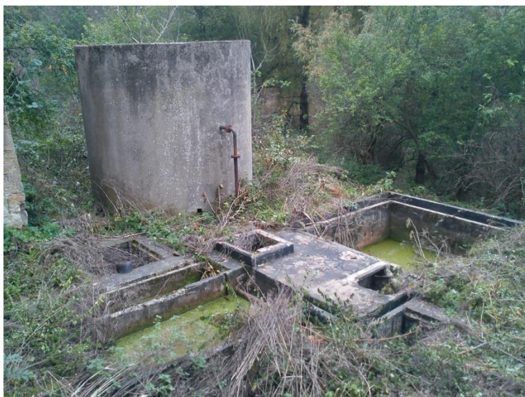
Obr. 4.9 – Pohled na ČOV směrem od zámku
