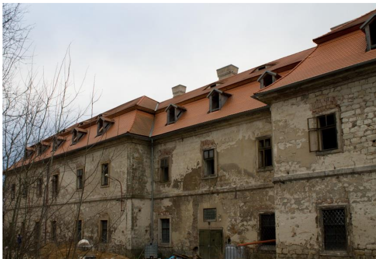
Obr. 4.1 – Pohled na objekt při příchodu do areálu
