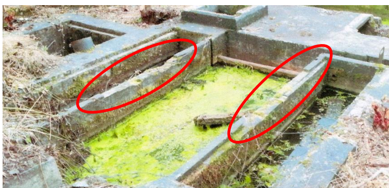
Obr. 4.10 – Pravděpodobné umístění česlí
