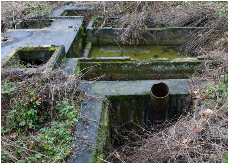
Obr. 4.15 – Pohled na odsávací potrubí a přeliv
