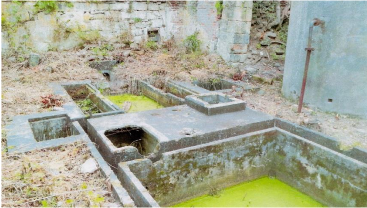
Obr. 4.11 – Pohled na nátokový objekt a usazovací nádrž
