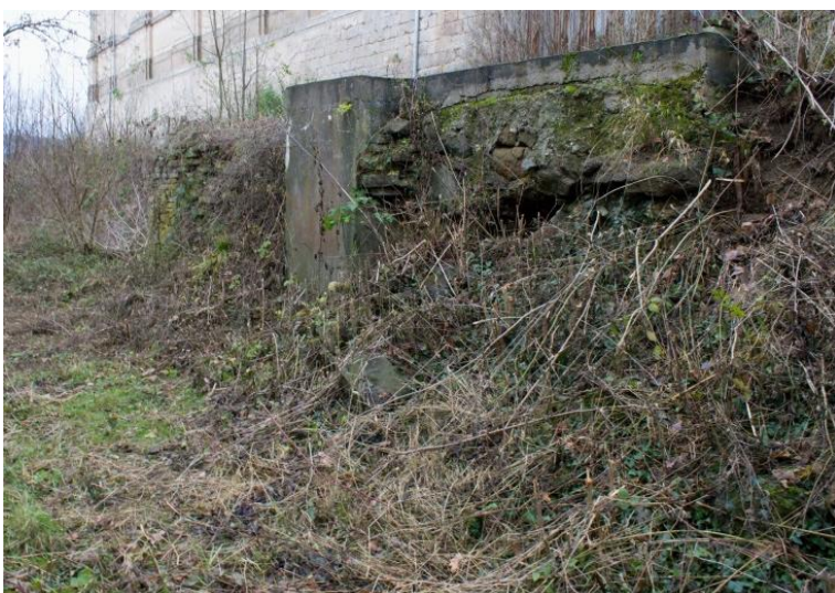
Obr. 4.7 – Pohled na stěnu čistírny
