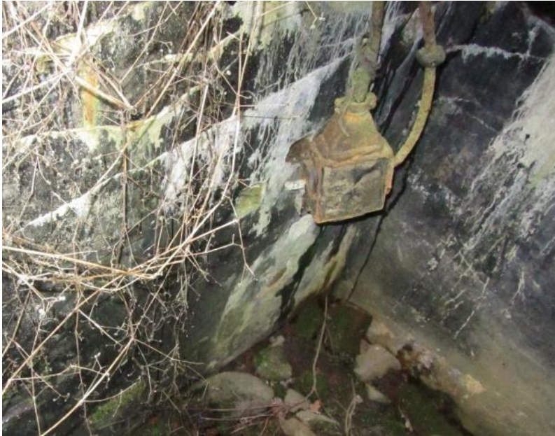
Obr. 4.18 – Ovládací zařízení čerpadla
