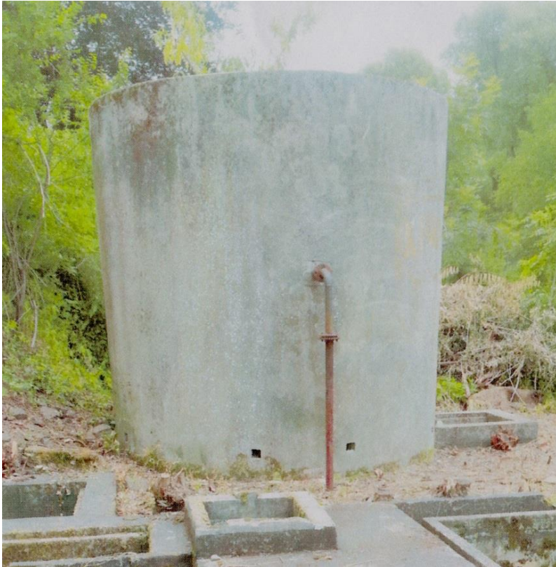
Obr. 4.20 – Zkrápěný rychlofiltr
