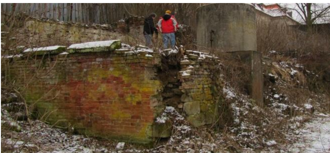
Obr. 4.8 – Opěrné zdi kolem objektu čistírny
