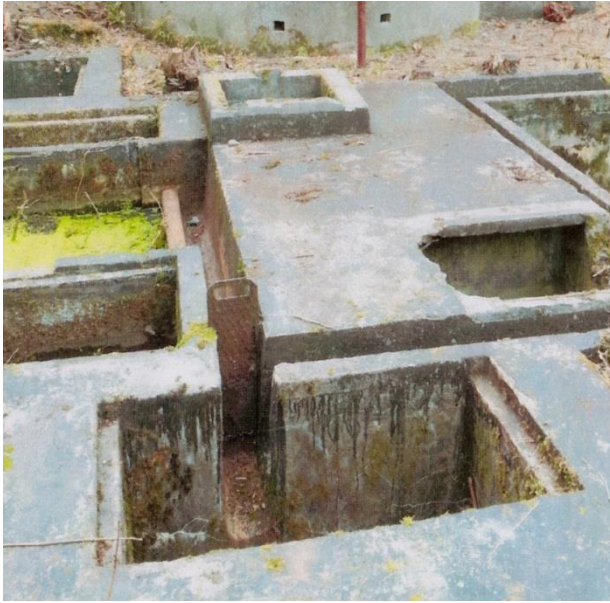
Obr. 4.16 – Pohled na žlab se stavítkem
