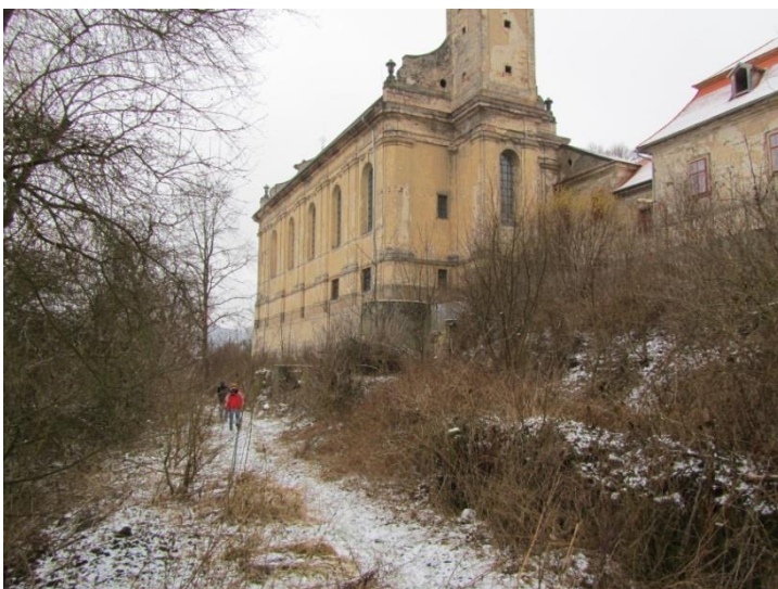
Obr. 4.3 – Přístupová cesta k čistírně
