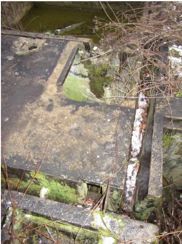
Obr. 4.17 – Pohled na vtok a stavítko
