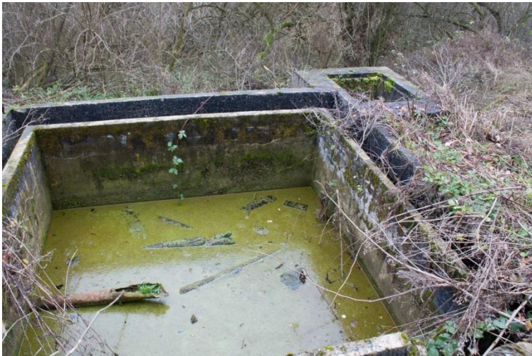
Obr. 4.24 – Pohled na výtokovou nádrž vedle dosazovací nádrže
