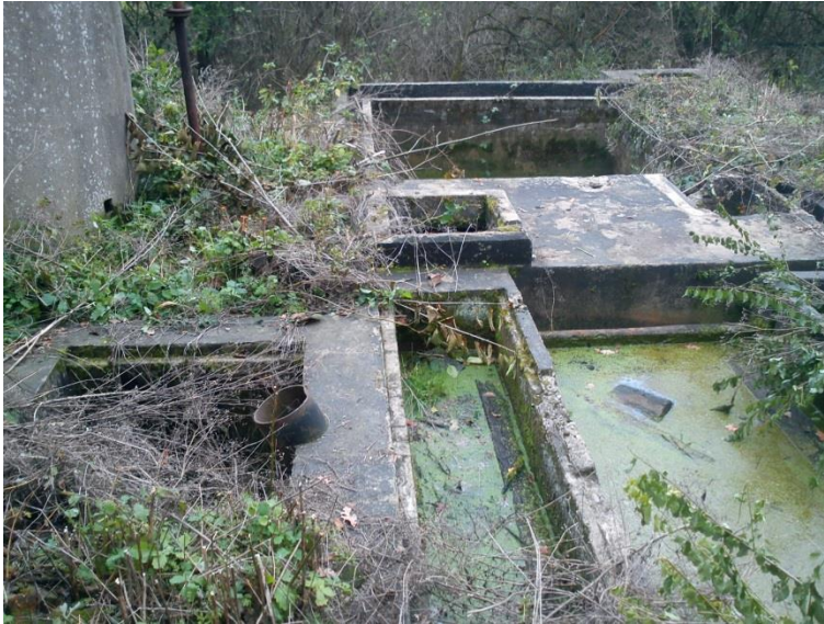
Obr. 4.14 – Usazovací nádrž s odsávacím potrubím
