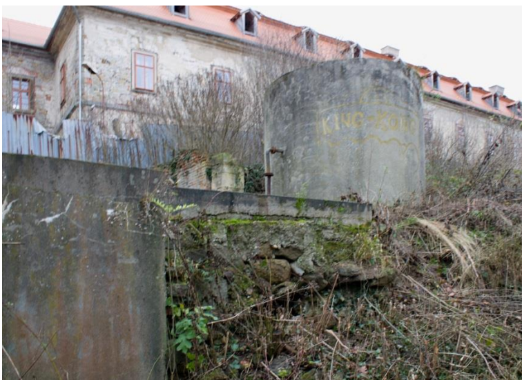
Obr. 4.6 – Pohled na stěnu čistírny s vystupující válcovou nádrží
