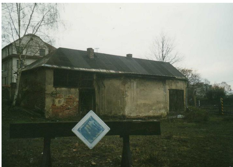
Obrázek 44 – Nevyužitá zděná budova. Zdroj: Archiv pana Petra Pačisky, Pražská teplotárenská a.s.
