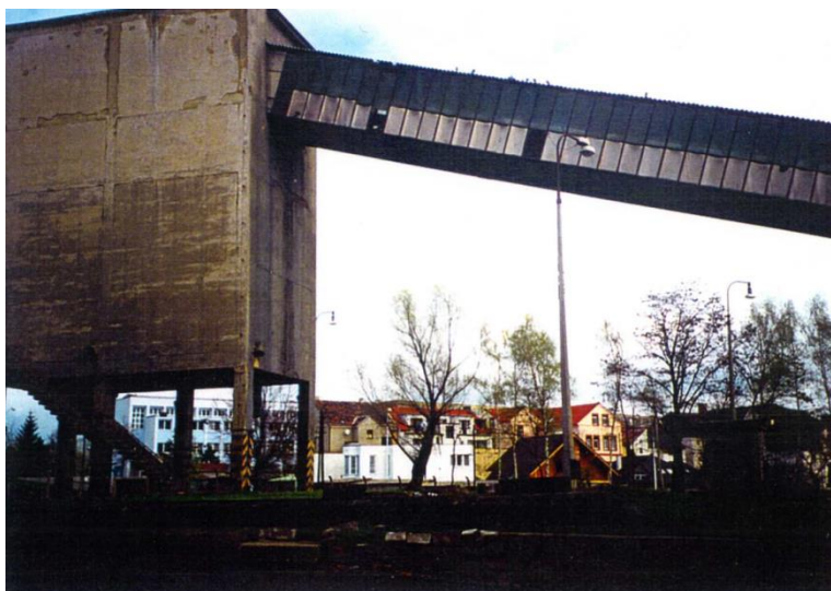
Obrázek 36 – Pohled na odstruskovací věž. Zdroj: Archiv pana Petra Pačisky, Pražská teplárenská a.s. – Zpráva: Demoliční práce na uhelné teplárně Veleslavín, pan Veselý, 5.5.1999.
