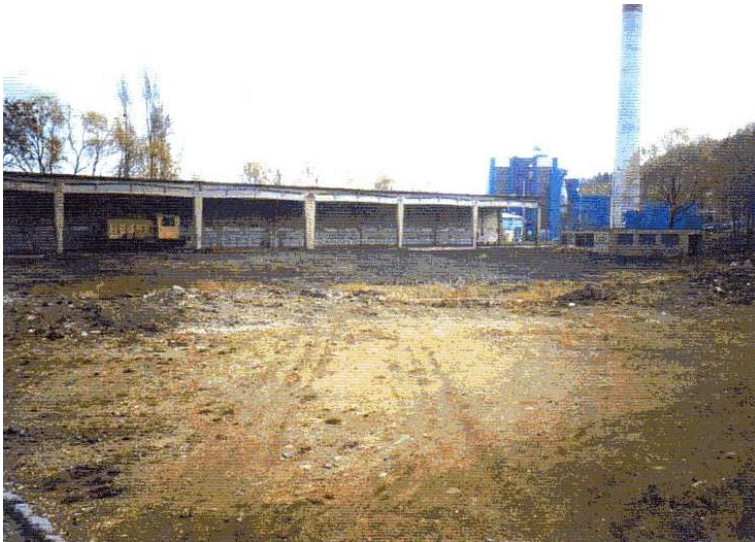
Obrázek 37 – Technologie zauhlování. Zdroj: Archiv pana Petra Pačisky, Pražská teplárenská a.s. – Zpráva: Demoliční práce na uhelné teplárně Veleslavín, pan Veselý, 5.5.1999.
