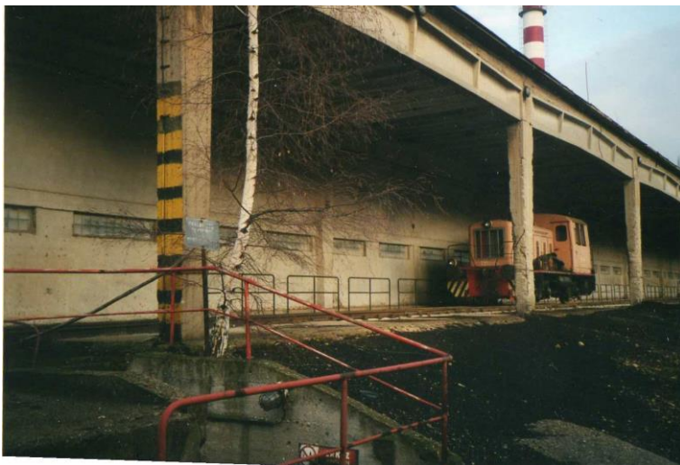
Obrázek 45 – Rampa na vykládání uhlí. Zdroj: Archiv pana Petra Pačisky, Pražská teplárenská a.s.
