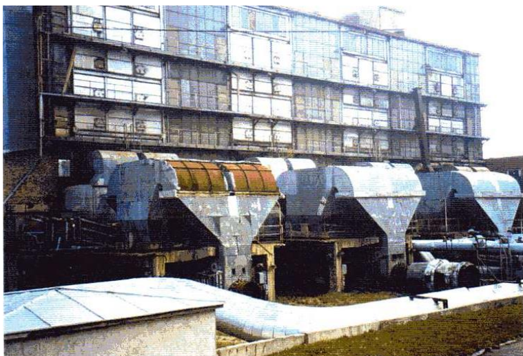
Obrázek 40 – Pohled na uhelné kotle. Zdroj: Archiv pana Petra Pačisky, Pražská teplotárenská a.s. – Zpráva: Demoliční práce na uhelné teplotárně Veveslavín, pan Veselý, 5.5.1999.
