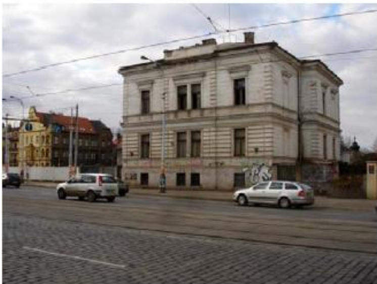
Obrázek 22 – Fotodokumentace Vila na Špejcharu. Zdroj: Operační program Praha: Konkurenceschopnost. HLAVNÍ MĚSTO PRAHA. Praha and EU: Evropské fondy v Praze [online]. 2013 [cit. 2014-03-16]. Dostupné z: http://www.prahafondy.eu/userfiles/File/OPPK-Dokumenty/CD_2 .
