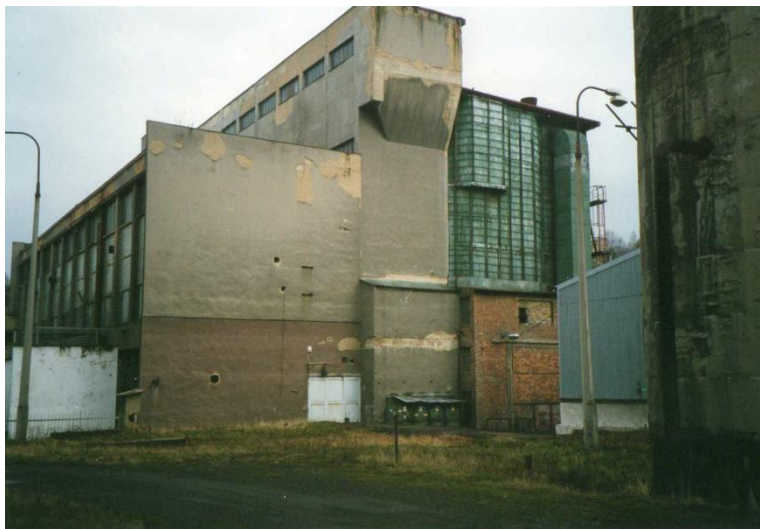
Obrázek 32 - Západní pohled na hlavní budovu teplárny. Zdroj: Archiv pana Petra Pačisky, Pražská teplárenská, a.s.
