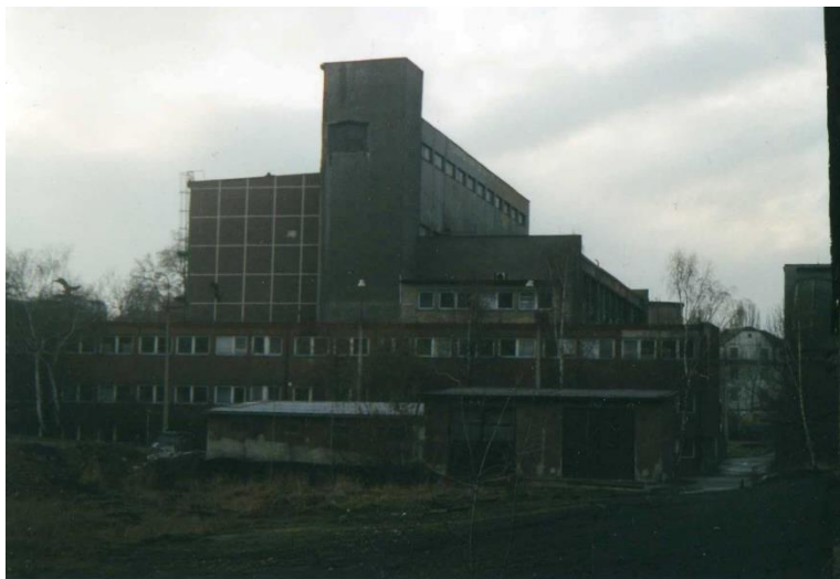
Obrázek 33 - Východní pohled na hlavní budovu teplárny a přistavěnou administrativní budovu. Zdroj: Archiv pana Petra Pačisky, Pražská teplárenská a.s.
