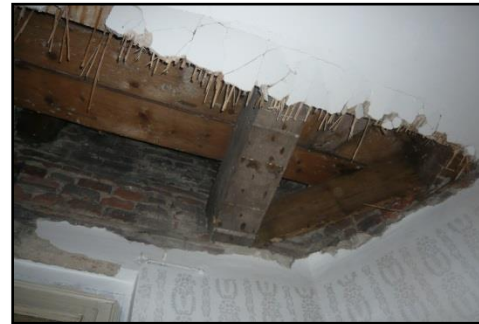
Obr. č. 11 - stropní konstrukce
