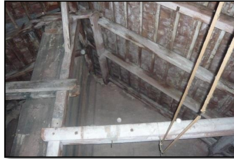
Obr. č. 9 - krov
