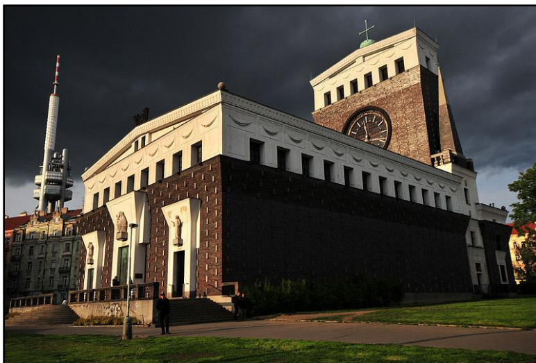
Obr. č. 4 - Kostel Nejsvětějšího srdce Páně + Žižkovská věž
