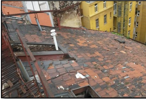
Obr. č. 8 - střecha
