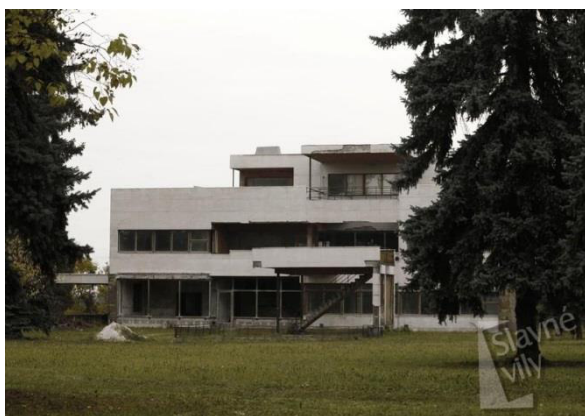
Obrázek 5: Stav objektu před rekonstrukcí
