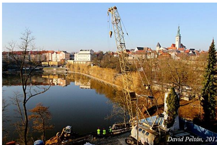
Obrázek 11. Pohled na hráz nádrfe Jordán
