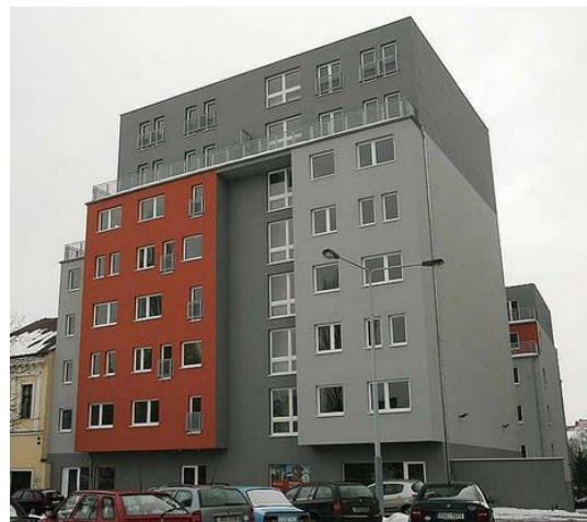
Obrázek 16: Bytový dům PIEROT 33
