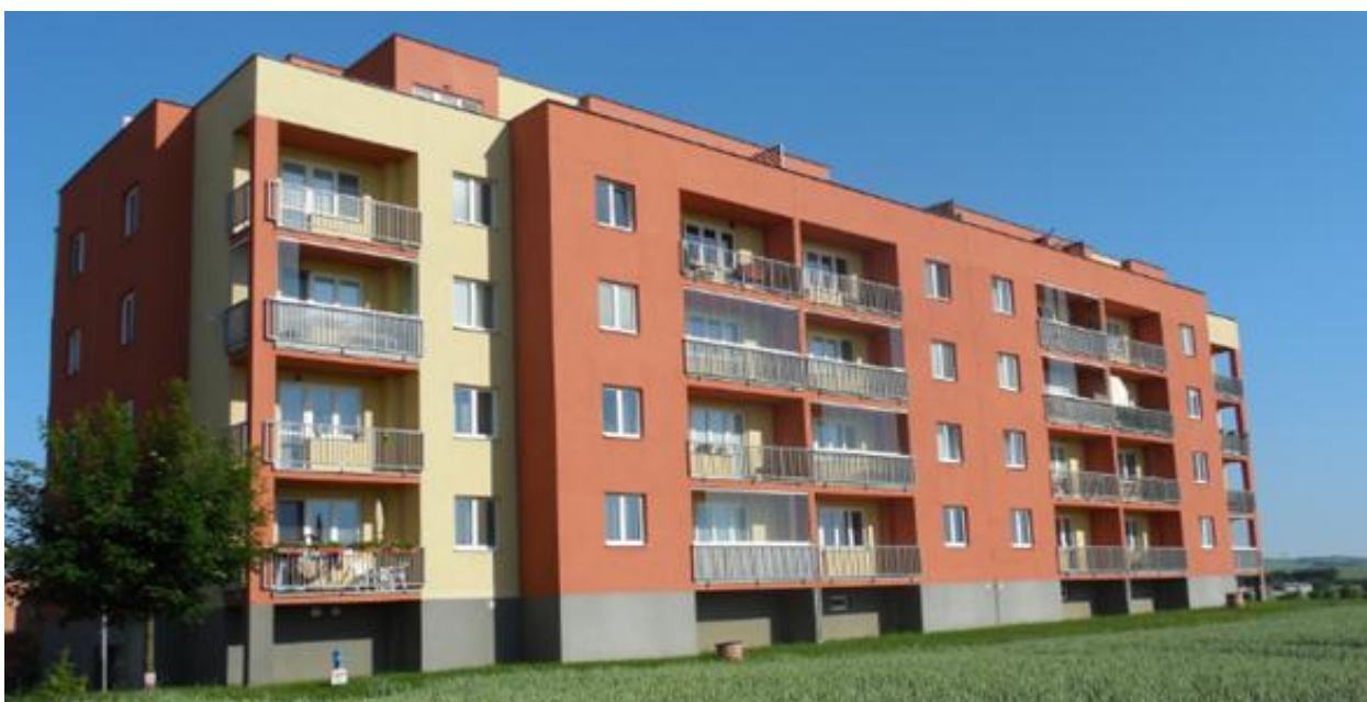
Obrázek 14: Stav objektu C (11. 8. 2014)
