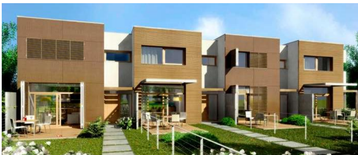
Obrázek 19: Řadové domy POD VODÁRNOU 36
