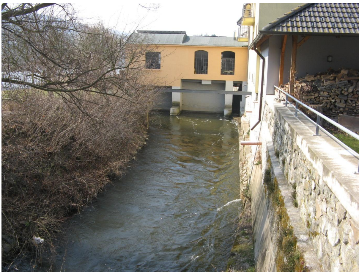
Obr. 3.1-2: Pohled na stávající odpadní kanál [16]
