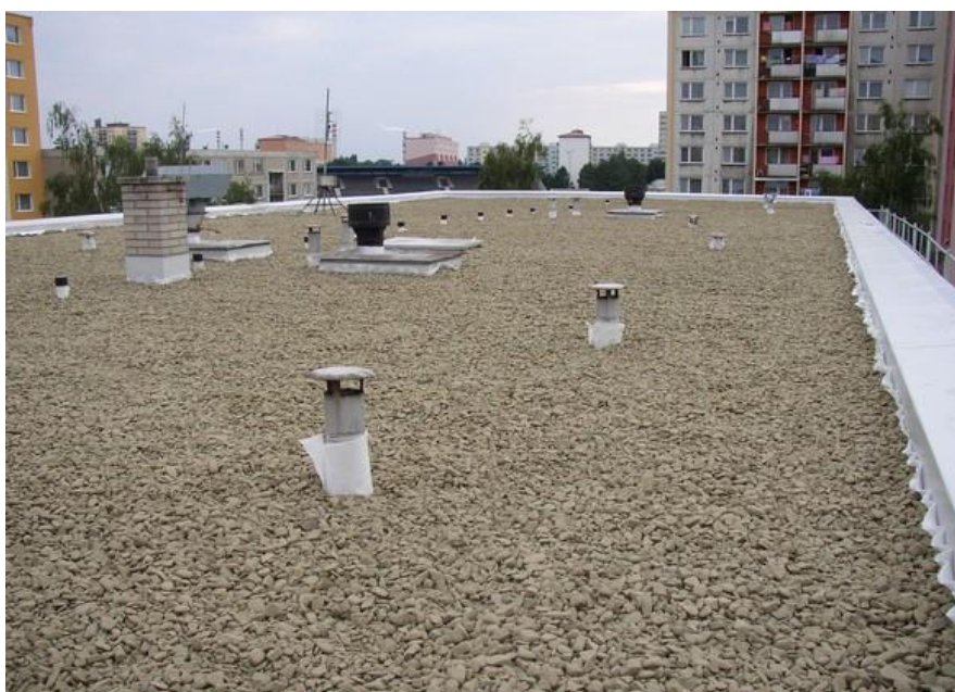
Obr. 20: Plochá střecha přitížená kamenivem [23]
