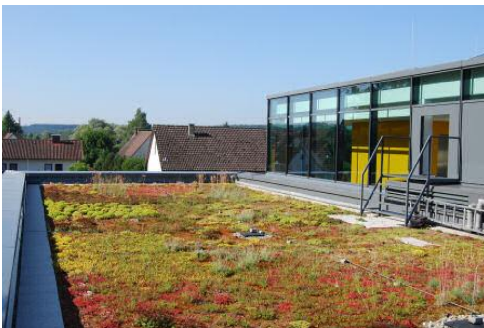
Obr. 13: zelená extenzivní střecha - úsporná varianta [5]
