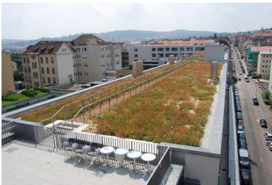
Obr. 15: Přírodní extenzivní střecha [5]
