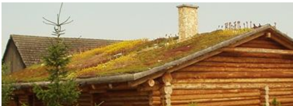
Obr. 5: Sklonitá zelená střecha [10].
