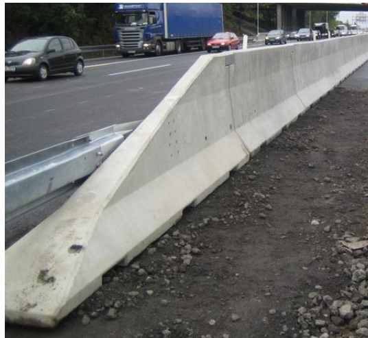
Obrázek 20: Betonové svodidlo
