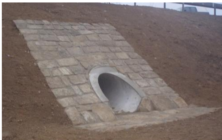
Obrázek 18: Trubní propustek
