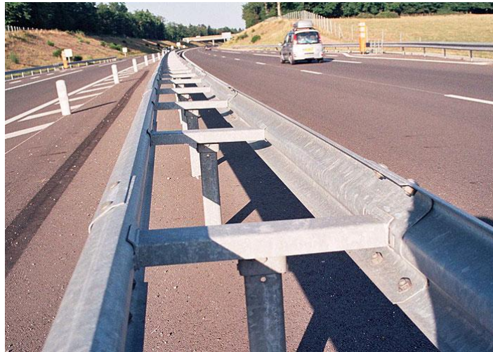
Obrázek 19: Oboustranné sloupové svodidlo
