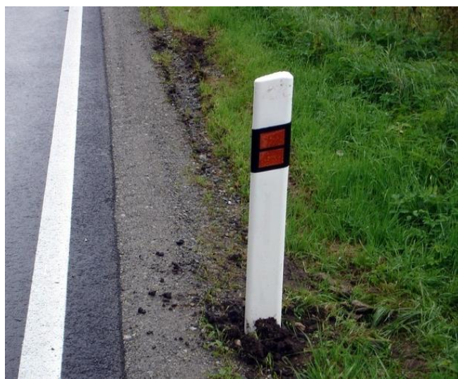
Obrázek 25: Silniční směrový plastový sloupek
