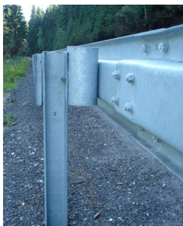
Obrázek 9: Ocelové svodidlo NH4
