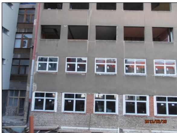
Obrázek 13: Výměna oken na fasádě
