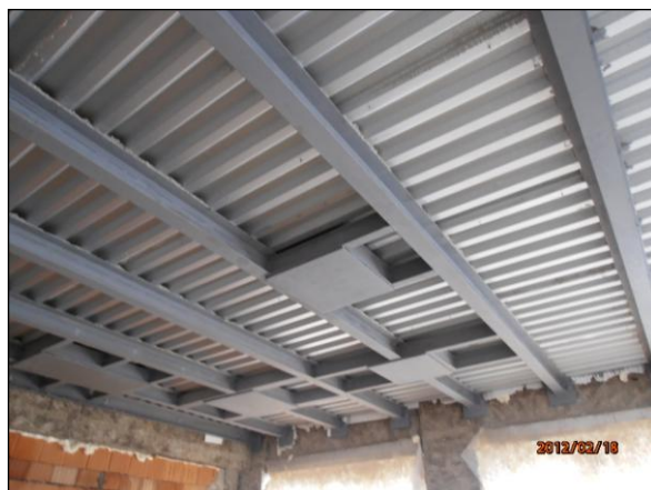
Obrázek 12: Nová část vybouraného stropu
