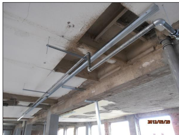
Obrázek 15: Provádění vnitřních instalací
