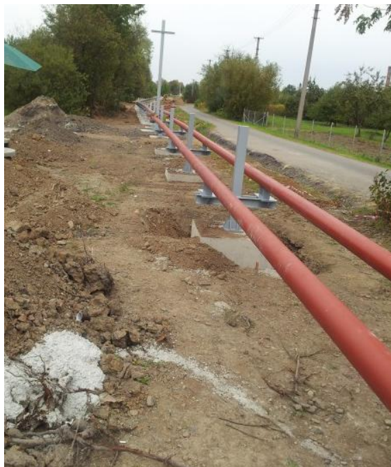
Obrázek 10: Ukázka ocelového potrubí.
