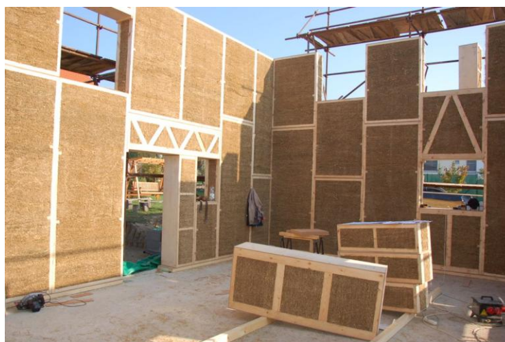
Obrázek 3: Stavba z panelů Ecococon
