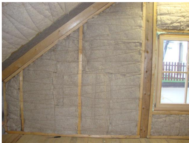
Obrázek 7: Ukázka zateplení pomocí lněné izolace Naturizol
