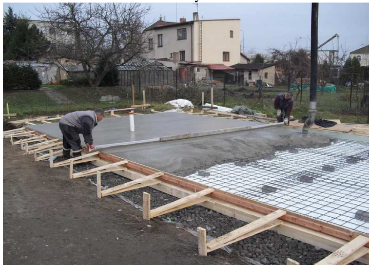
Obr.6 Realizace základové desky
