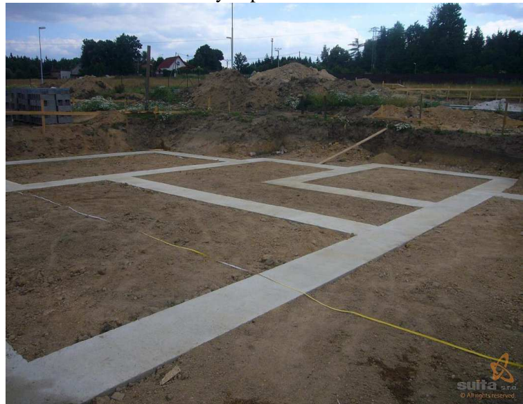
Obr.3 Realizace základových pásů
