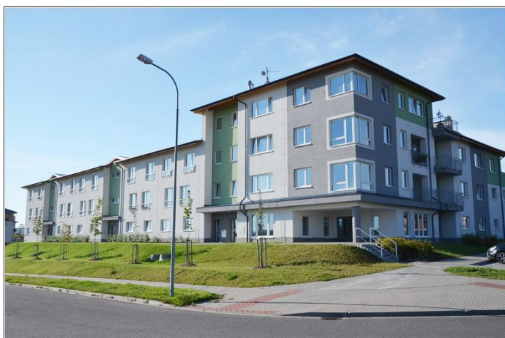
Obr. 3 Bytový dům 26 BJ, zdroj: www.vystavbaklafar.cz
