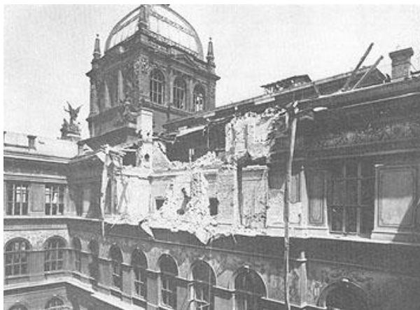
Obr. 3: Poškození hlavní budovy Národního muzea po zásahu leteckou pumou 7. května 1945 [16]
