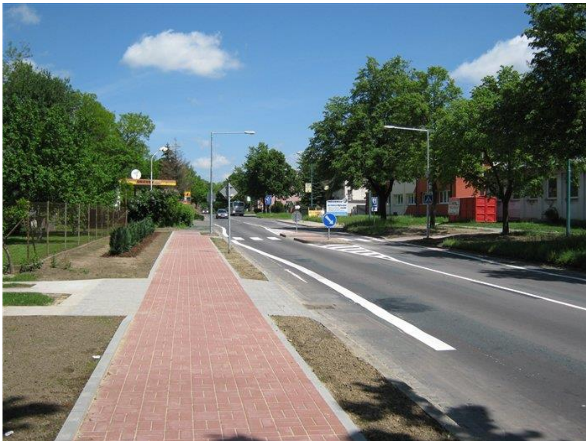
Obrázek č. 10: Zvýšený chodník se zeleným pásem, osvětleným přechodem s ostrůvkem a změnou struktury dlažby ve Veselí nad Moravou.
