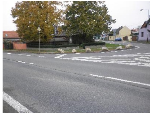
Obrázek 5.11: Ostrý úhel odbočení u křižovatky v Bezděčíně
