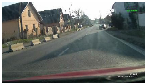
Obrázek 5.8: Betonová svodidla na kraji vozovky v obci Bezděčín
