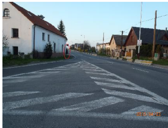
Obrázek 5.12: Vyznačená zeleň, která omezuje dopravní poměry v křižovatce
