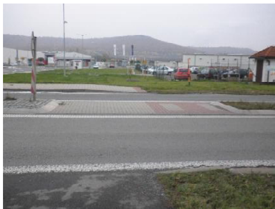
Obrázek 5.17: Špatně užitě prvky pro nevidomé a slabozraké
