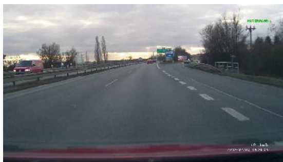
Obrázek 5.4: Krátké svodidlo bránící nárazu do zábradlí
