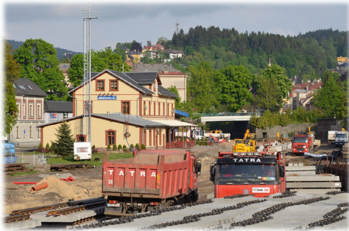
Obrázek 52.: Kompletní přestavba kolejiště spojená s výstavbou nástupišť. Jablonec nad Nisou 2015.
