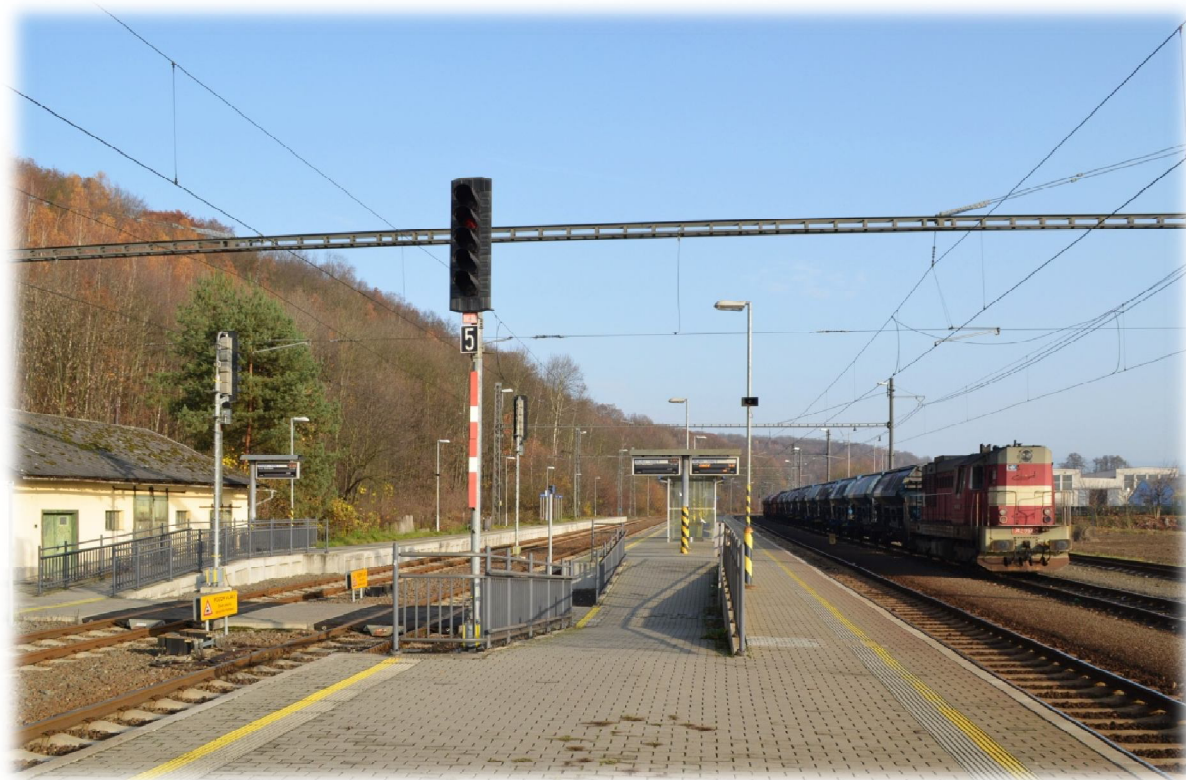
Obrázek 25.: Kolej č. 1 vpravo od nástupiště umožňuje průjezd stanicí traťovou rychlostí. Bludov 2014.
