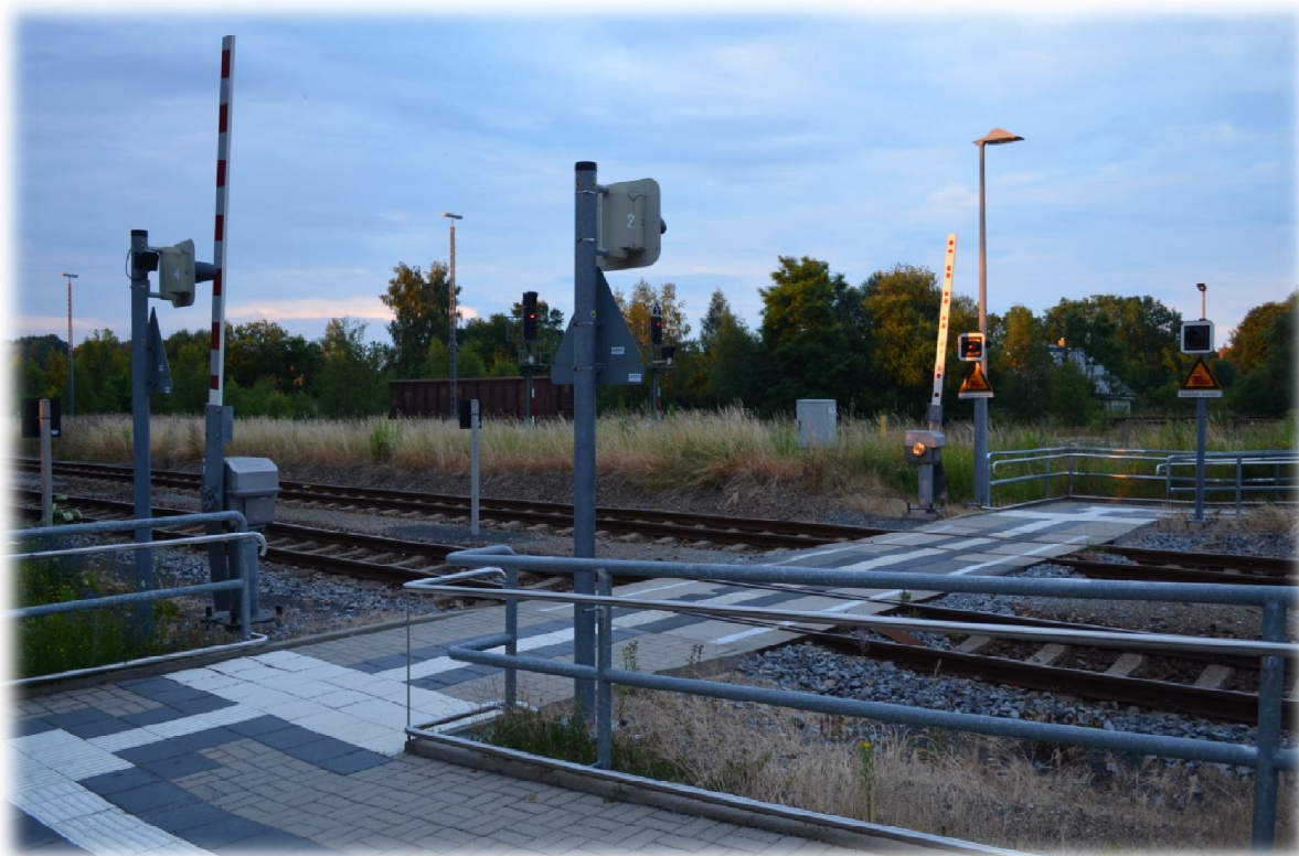
Obrázek 9.: Zahraniční obdoba centrálního přechodu se závorami a signalizací. Ebersbach 2014.
