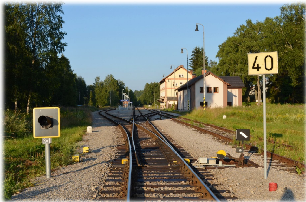
Obrázek 20.: Přednostní polohu samovratné výhybky předurčuje centrální přechod. Nová Pec 2012.
