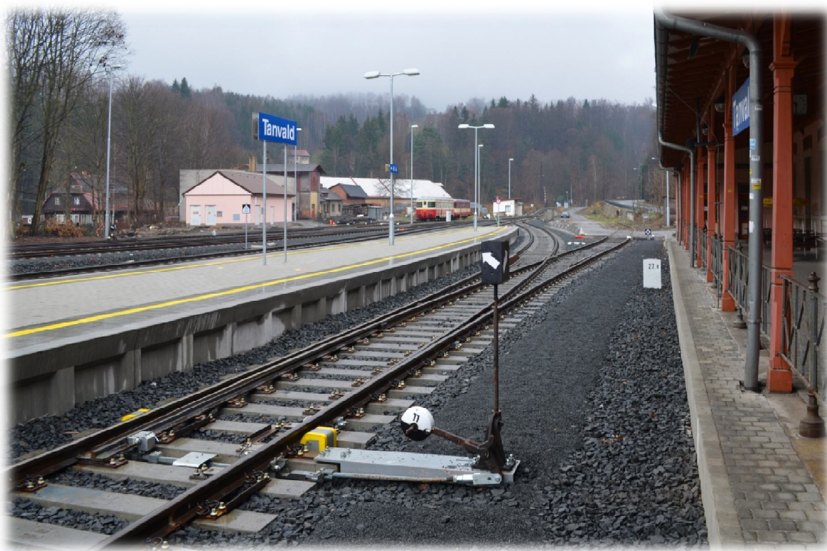
Obrázek 5.: Výhybka v koleji přilehlé k nástupní hraně poloostrovního nástupiště. Tanvald 2014.
