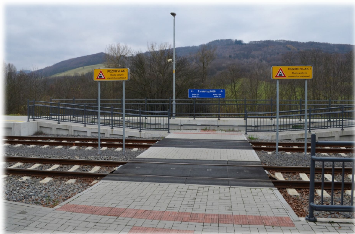
Obrázek 15.: Varovný pás při vstupu na centrální přechod odsazený od pásu signálního. Bylnice 2014.
