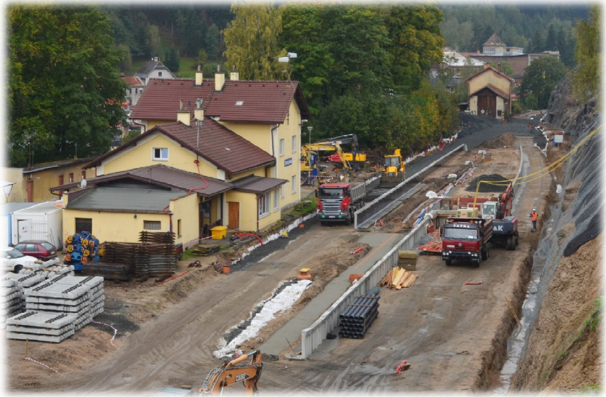
Obrázek 50.: Výstavba poloostrovního nástupiště s jazykovou částí v přípojně stanici. Smržovka 2014.
