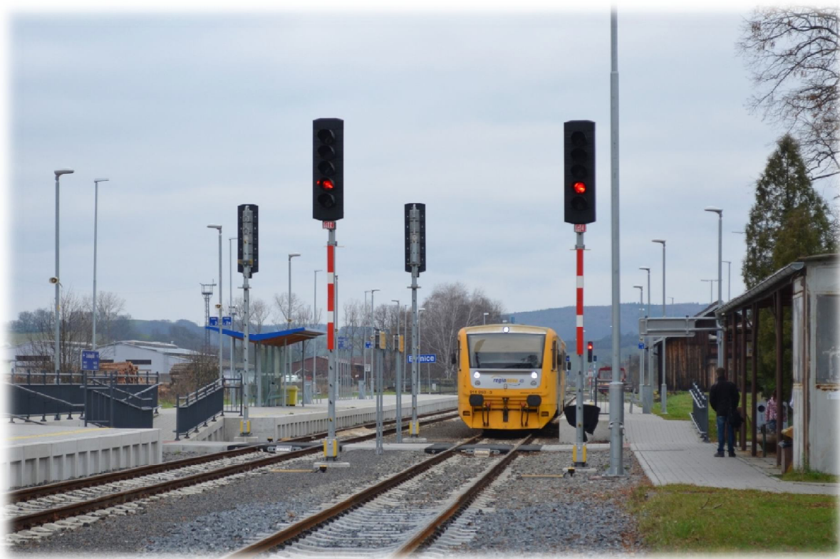
Obrázek 19.: Cestová návěstidla kryjící centrální přechod na poloostrovní nástupiště. Bylnice 2015.
