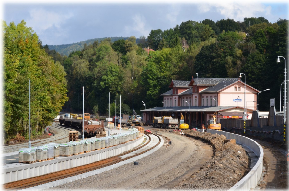
Obrázek 48.: Rekonstrukce stanice spojená s výstavbou poloostrovních nástupišť. Tanvald 2014.
