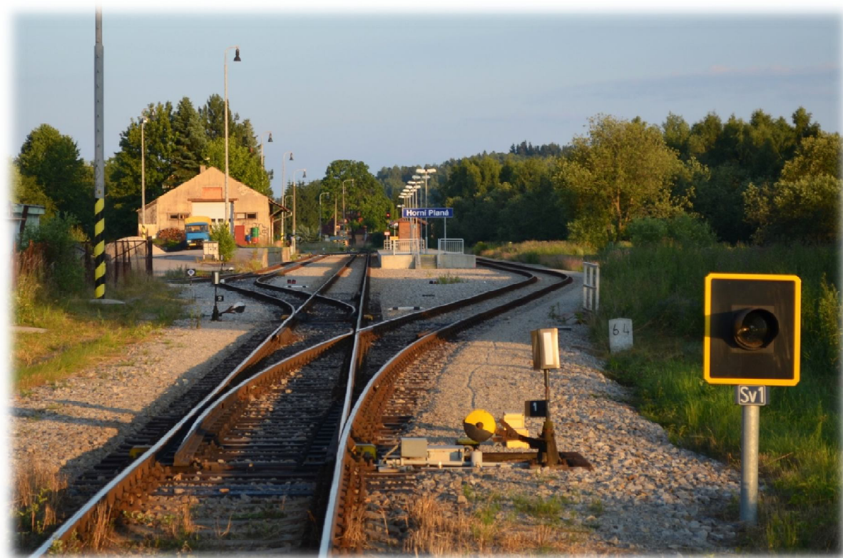
Obrázek 45.: Řešení se samovratnými výhybkami během provozu trati v režimu D3. Horní Planá 2012.
