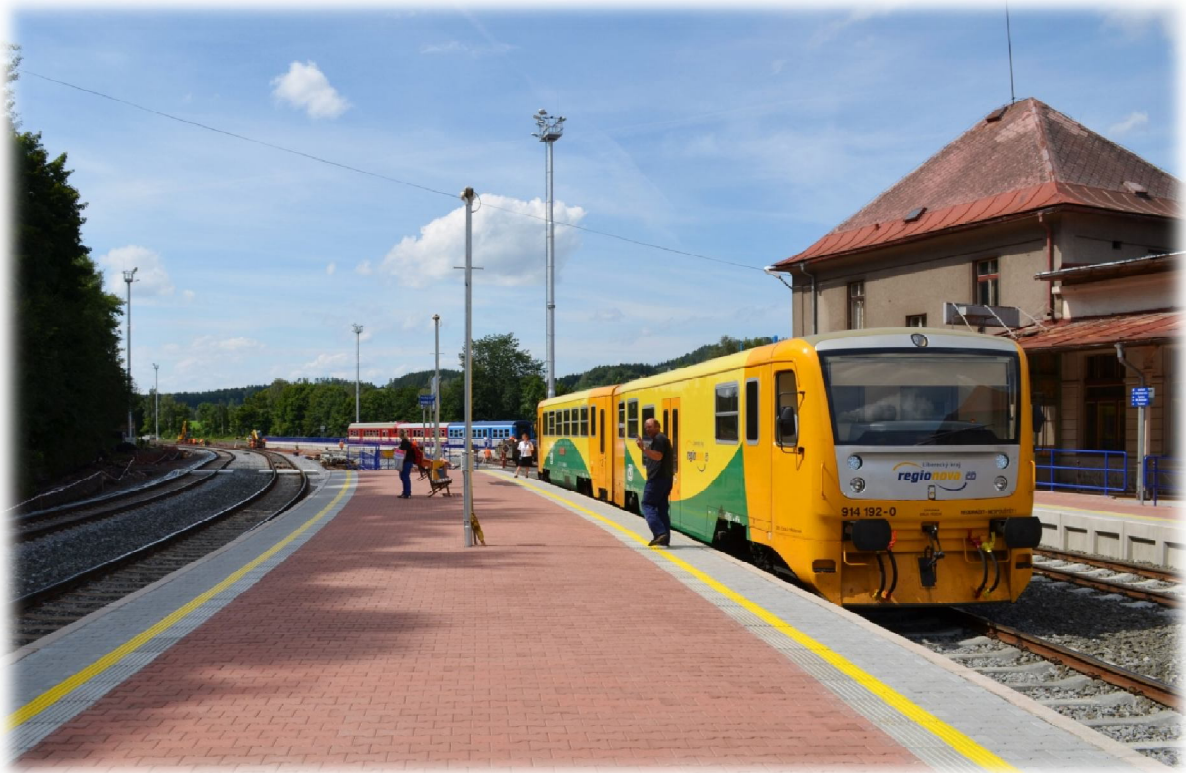
Obrázek 34.: Oboustranné poloostrovní nástupiště v průběhu rekonstrukce stanice. Stará Paka 2012.
