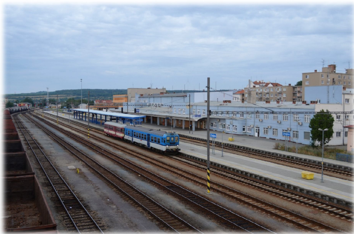
Obrázek 40.: Celkový pohled na poloostrovní a vnější nástupiště a výpravní budovu. Znojmo 2014.
