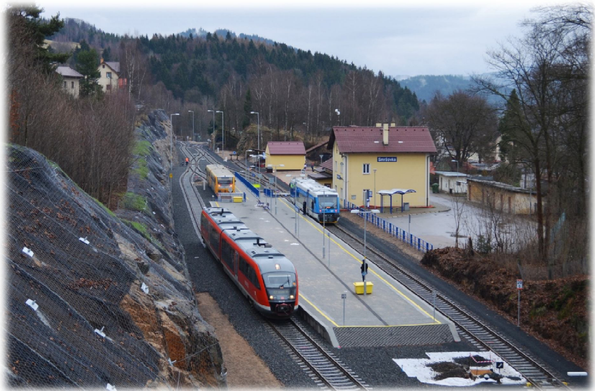
Obrázek 51.: U tohoto nástupiště mohou být realizovány všechny přestupní vazby. Smržovka 2014.
