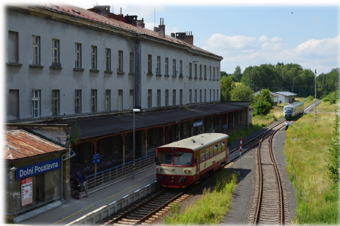
Obrázek 23.: Negativní příklad umístění nástupiště u zchátralé výpravní budovy. Dolní Poustevna 2013.
