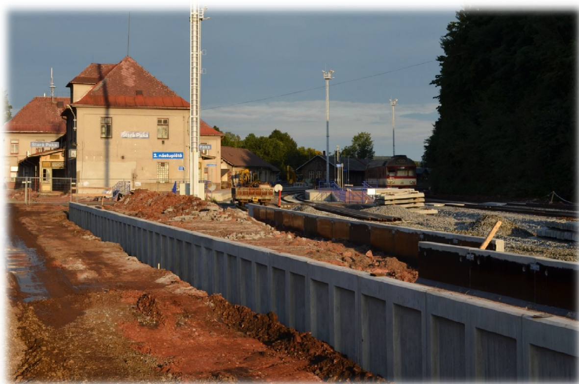
Obrázek 3.: Výstavba poloostrovního nástupiště za použití nástupištních zídek typu L. Stará Paka 2012.
