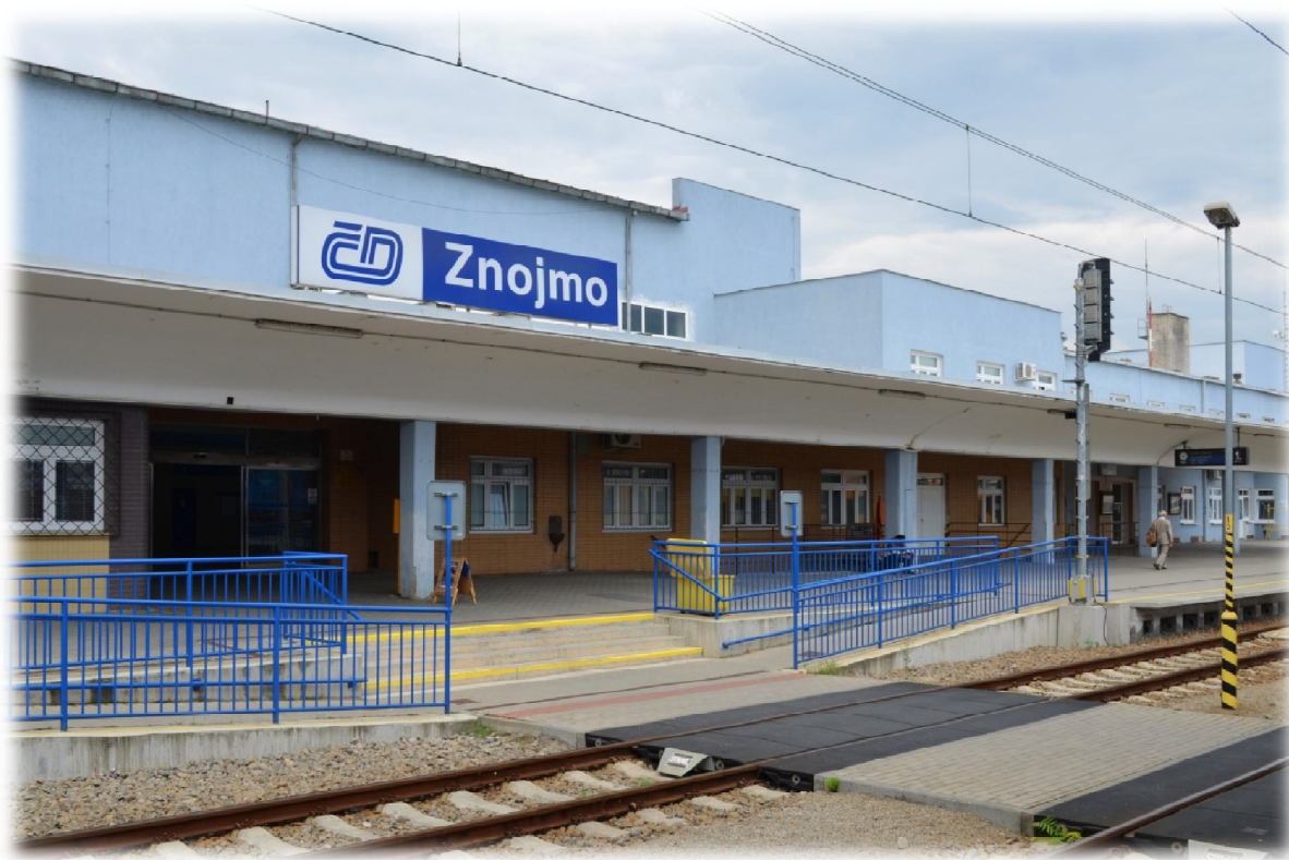
Obrázek 6.: Kombinace schodiště a šikmých ramp při vstupu na centrální přechod. Znojmo 2014.
