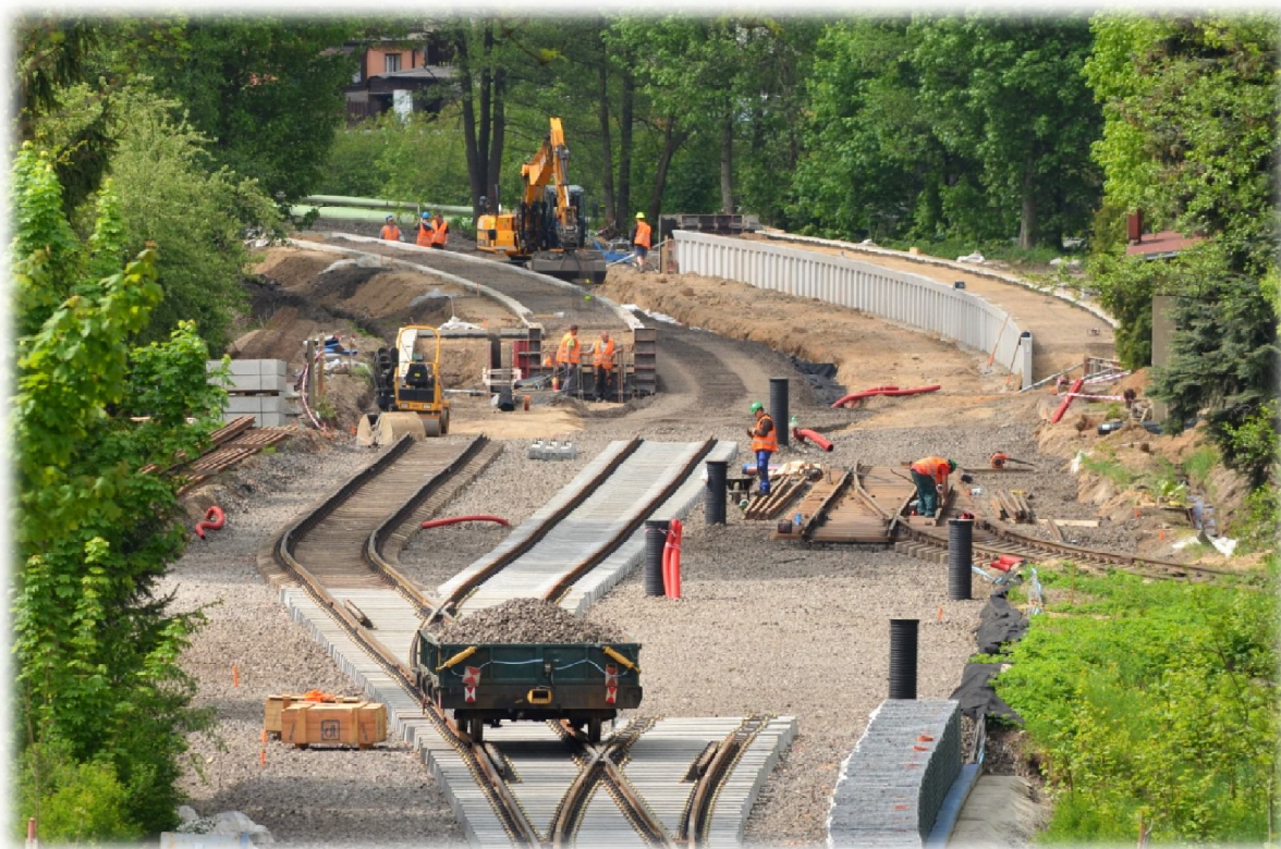
Obrázek 54.: Výstavba vnějších nástupišť na protilehlých stranách kolejiště. Vesec u Liberce 2015.
