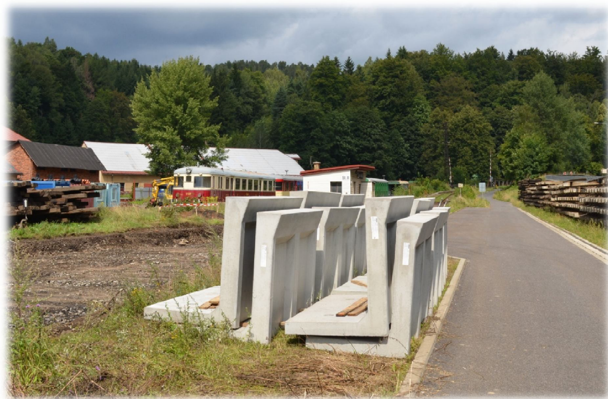
Obrázek 2.: Nástupištní zídky typu H připravené k realizaci poloostrovního nástupiště. Tanvald 2014.
