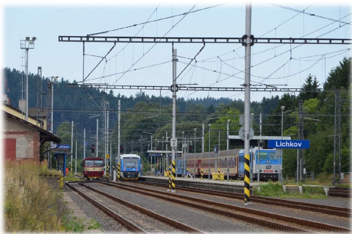
Obrázek 12.: Umístění názvu stanice na čele poloostrovního nástupiště vybaveného též IS. Lichkov 2013.
