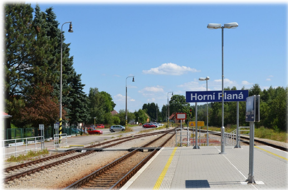
Obrázek 44.: Zakončení poloostrovního nástupiště ve vazbě na centrální přechod. Horní Planá 2012.
