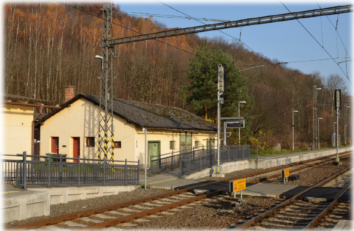
Obrázek 37.: Šikmé rampy u centrálního přechodu při přístupu na vnější nástupiště. Bludov 2014.
