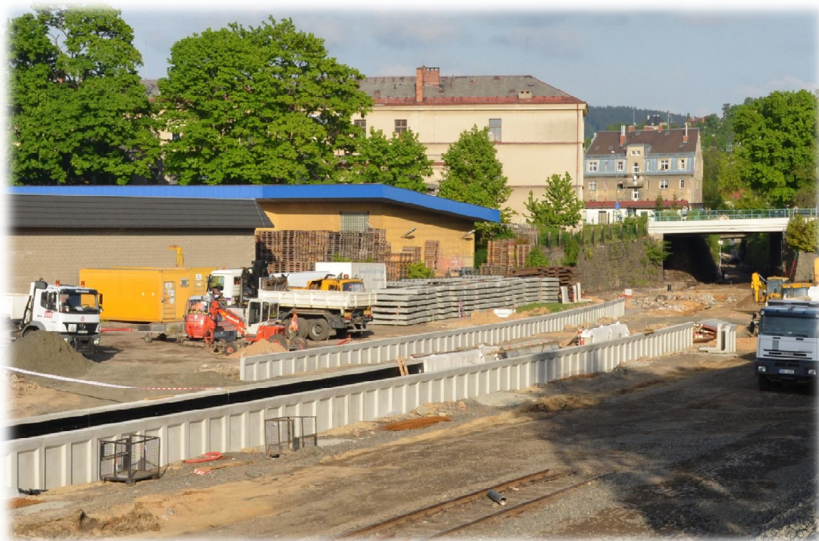
Obrázek 53.: Realizace jednostranného poloostrovního a vnějšího nástupiště. Jablonec nad Nisou 2015.
