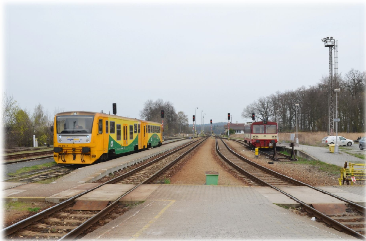
Obrázek 17.: Směrová úprava koleje vyvolaná potřebou vložit poloostrovní nástupiště. Březnice 2014.
