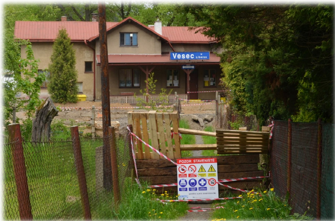
Obrázek 55.: Zde vznikne přechod přes kolejiště s přejezdovým zabezpečením. Vesec u Liberce 2015.
