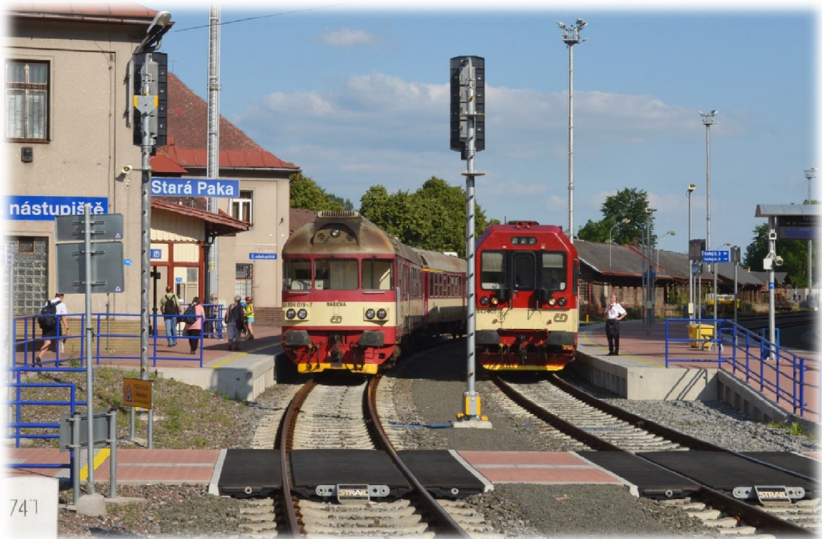
Obrázek 35.: Centrální přechod na poloostrovní nástupiště s cestovými návěstidly. Stará Paka 2013.
