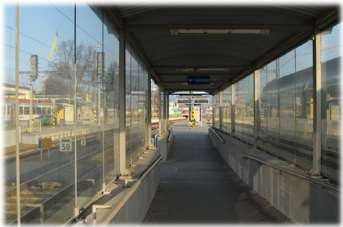
Obrázek 8.: Skleněné plochy zhoršují rozhledové poměry na centrálním přechodu. Šumperk 2014.
