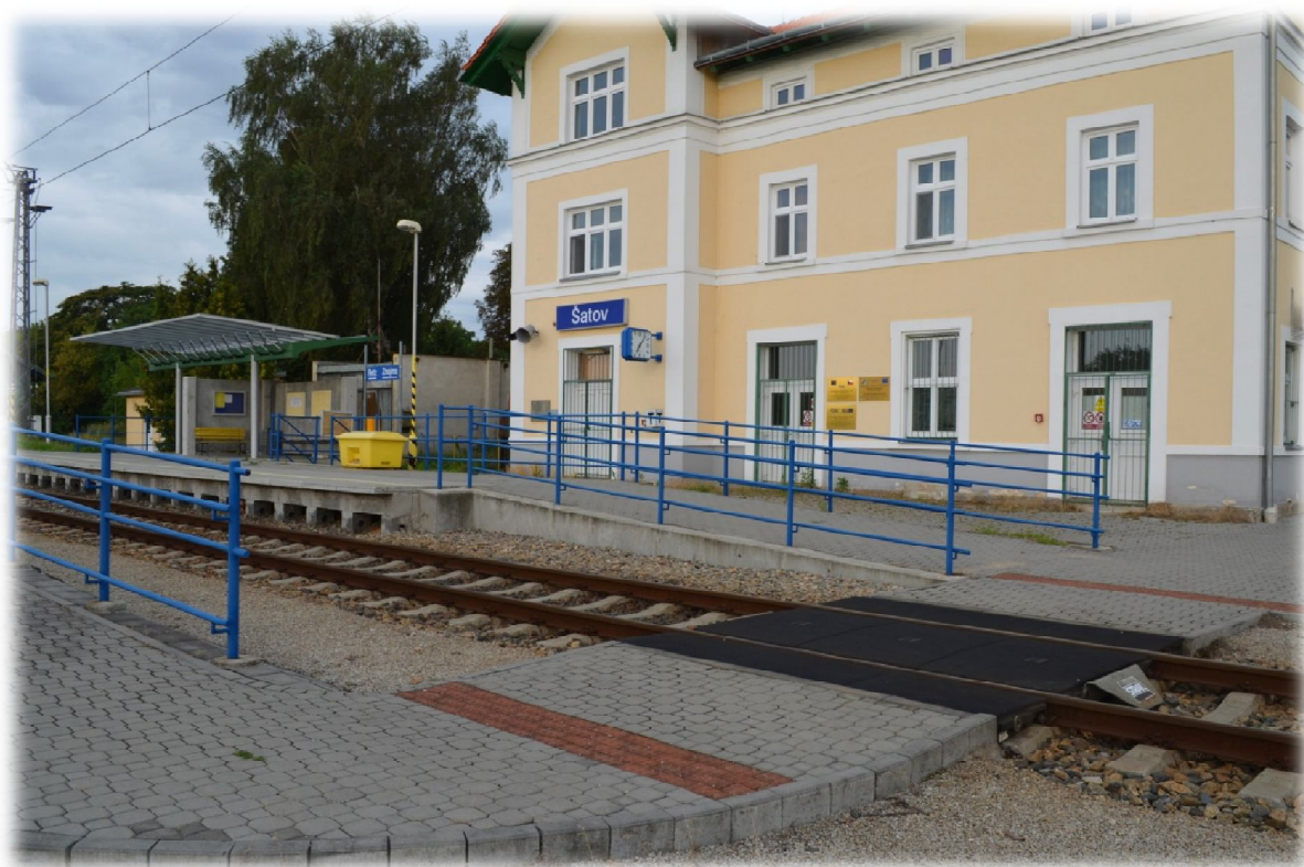
Obrázek 42.: Detail řešení přístupu na poloostrovní nástupiště centrálním přechodem. Šatov 2014.
