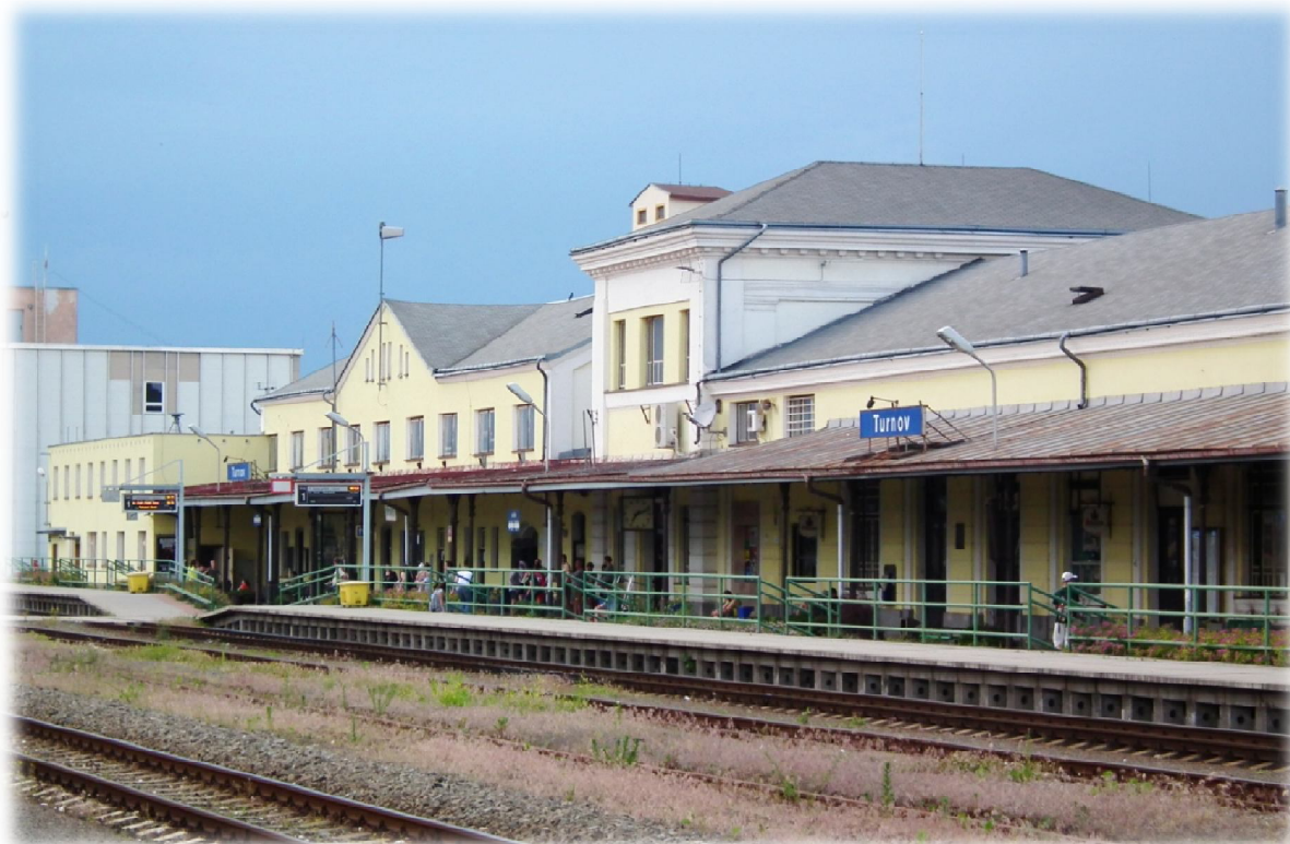
Obrázek 1.: Konstrukce vnějšího nástupiště typu SUDOP využívající konzolových desek. Turnov 2010.
