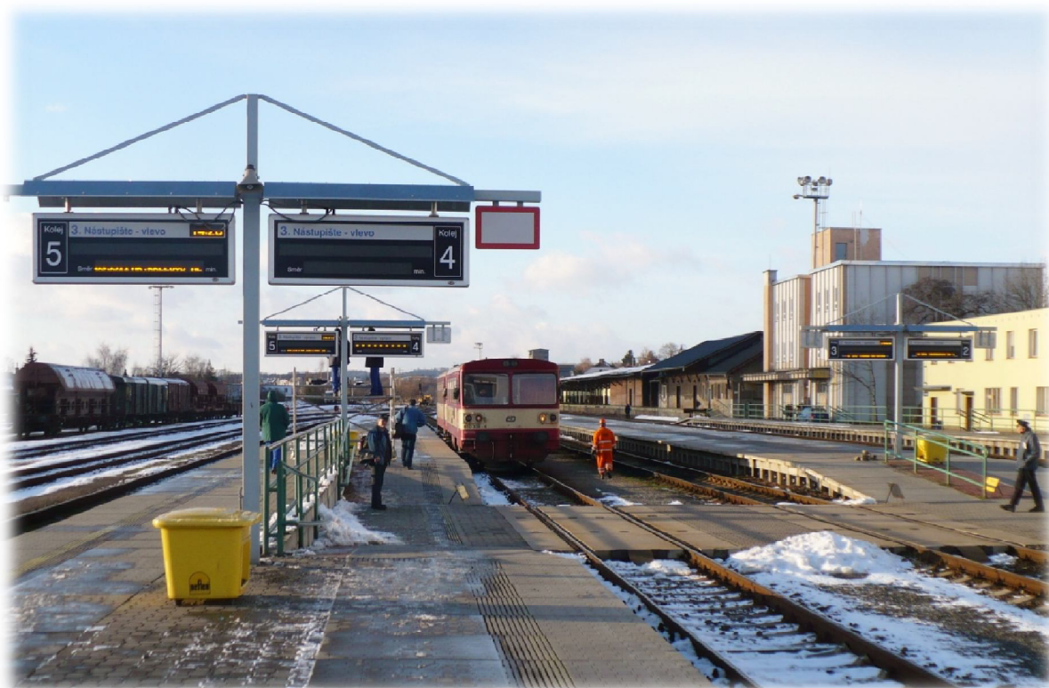
Obrázek 13.: Instalace závěsných informačních tabulí na poloostrovni nástupiště. Turnov 2007.
