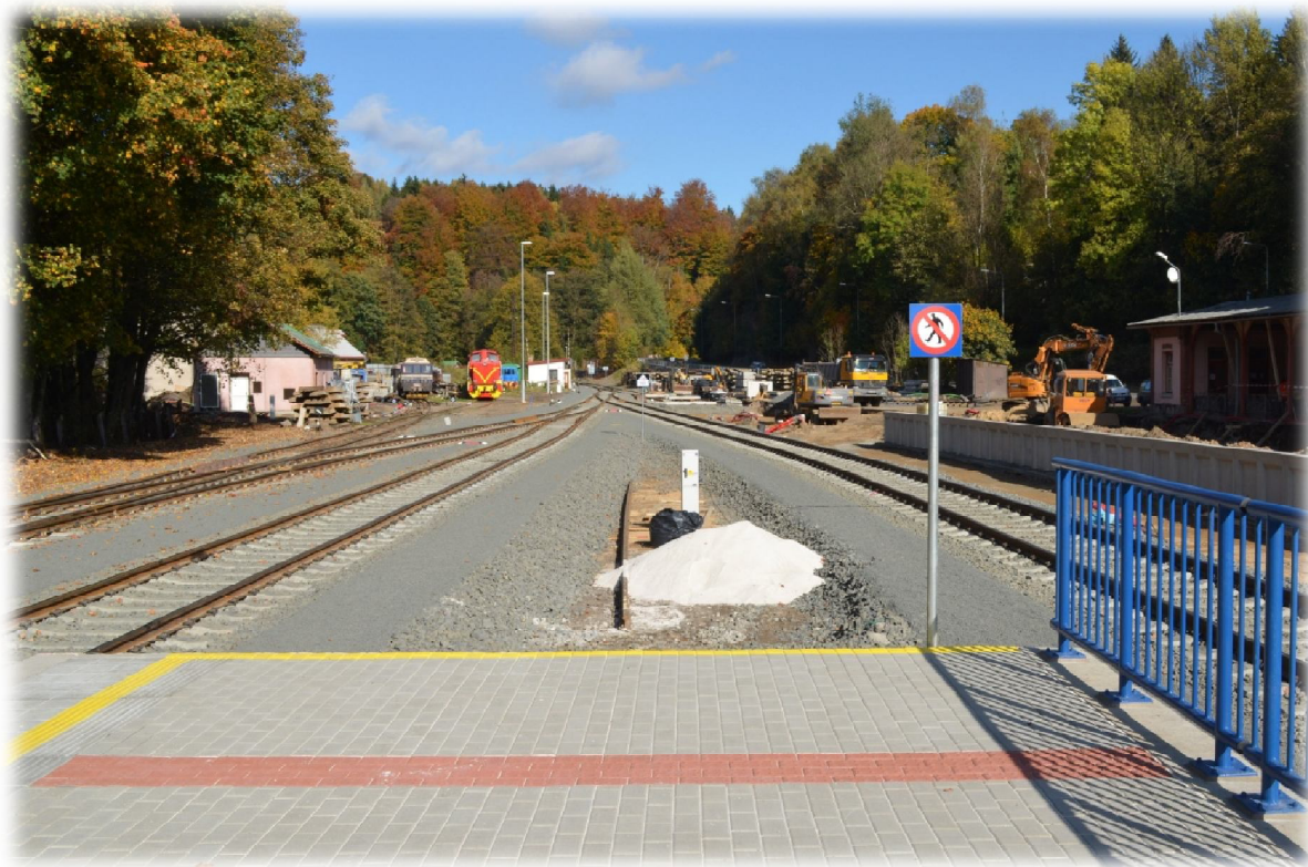
Obrázek 14.: Ukončení poloostrovního nástupiště varovným pásem o šířce 400 mm. Tanvald 2014.
