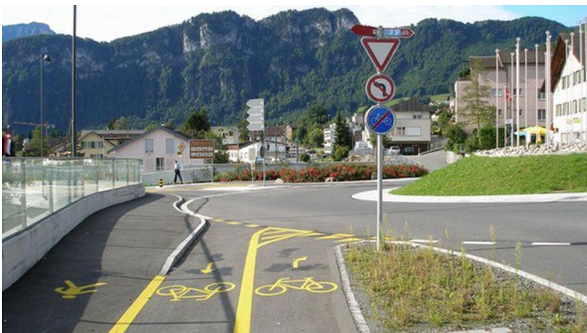
Obrázek 26 - Příklad jednoho ramene okružní křižovatky pro cyklisty z Matterbodenu ve Švýcarsku [17]
