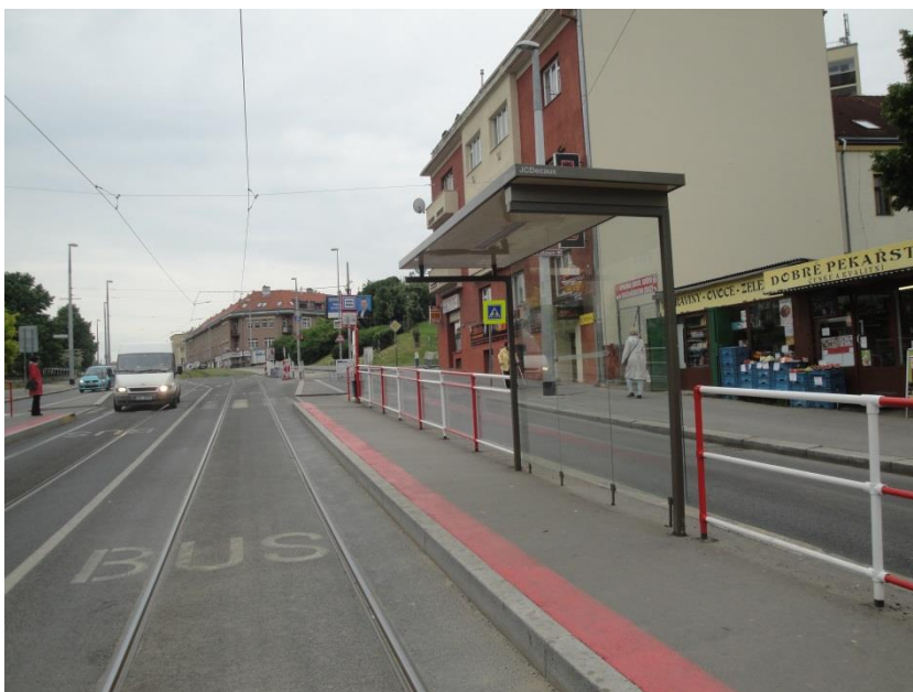
Obrázek 23 – Přístřešek bez bočních stěn a lavičky. Vzadu je vidět označnick zastávky, jehož spodní část konstrukce je otočena o 90°.
