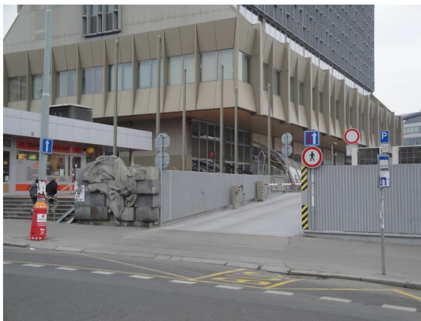
Obrázek 9 - Vstup do metra z ulice Děkanská vinice I, vpravo je zakázaný vstup chodců na rampu vedoucí na parkoviště, vlevo schody vedoucí ke vstupu do metra.
