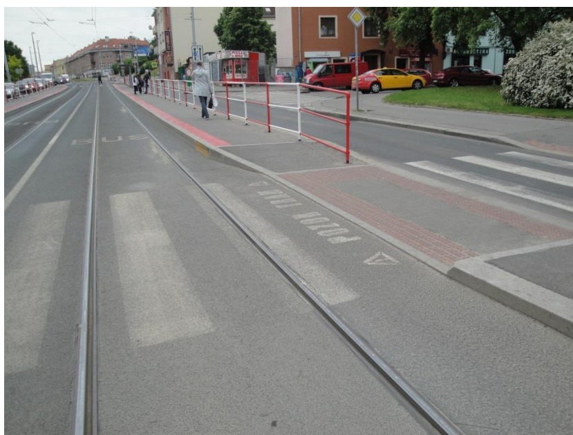
Obrázek 26 - Šikmá rampa a hmatové prvky u přístupu na zastávku
