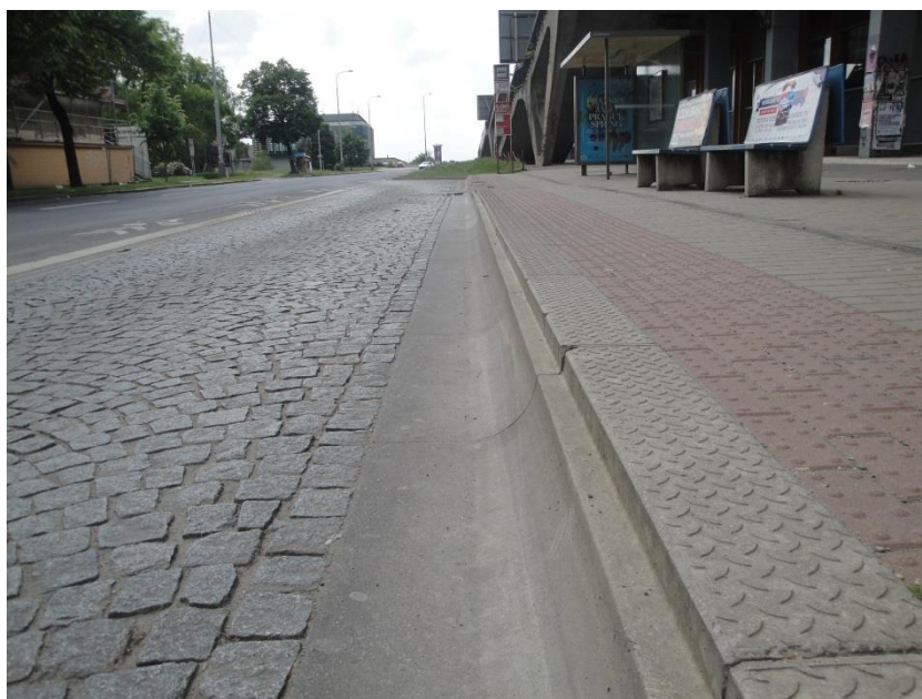
Obrázek 24 - Detail kasselského obrubníku
