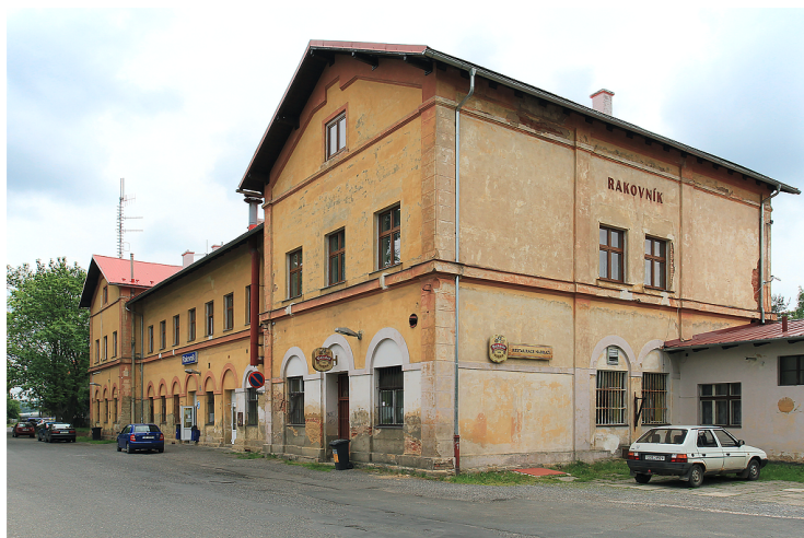
Obrázek 4: Výpravní budova žst. Rakovník
