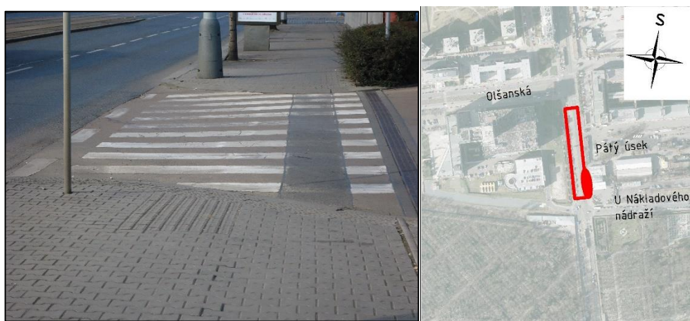
Obr. 11 – Přechod u benzínové pumpy [A]
