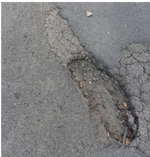
Obrázek 16 - Výtluk v blízkosti řešené křižovatky
