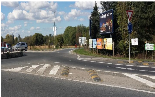
Obrázek 12 - Příčné prahy umístěné v křižovatce
