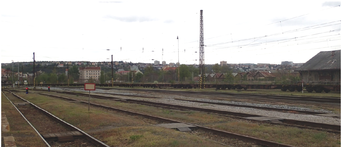
Obrázek 46: Železniční stanice Praha-Bubny má dnes již velké množství zbytných ploch. Po rekonstrukci této stanice by zde měly zůstat jen čtyři dopravní koleje. Samotná niveleta kolejí bude výše než dnes.
