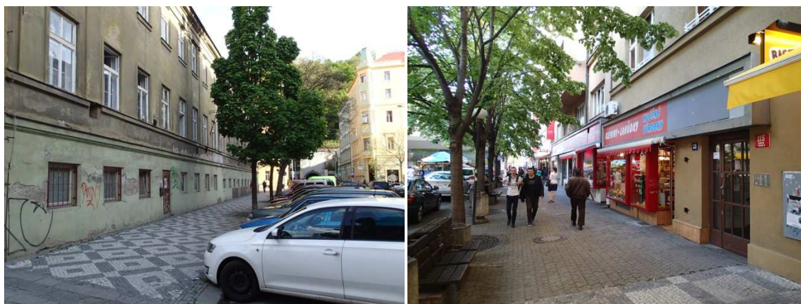
Obrázek 26 (vlevo): Nefunkční parter v ulici Thámova. Plocha ulice převážně slouží k dopravě v klidu. V pozadí portál pěšího tunelu pod Vítkovem.
