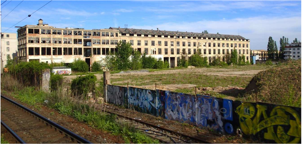
Obrázek 33: Ukázka velkého brownfieldu v oblasti železniční zastávky Praha-Daňkova. Tato oblast má velký potenciál dalšího rozvoje území.
