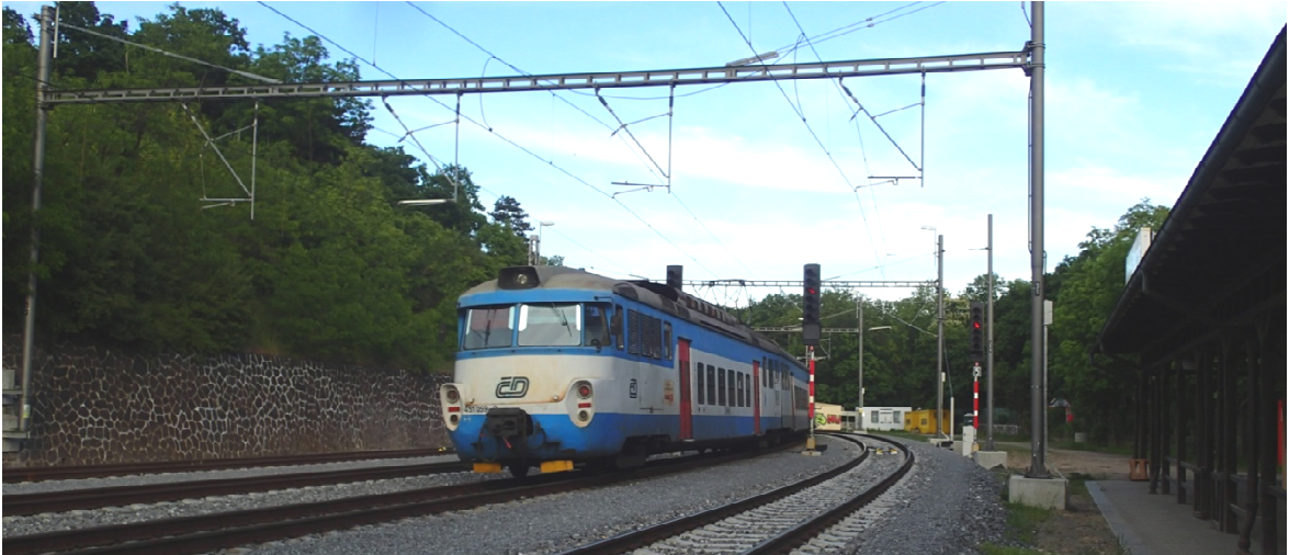
Obrázek 52: Původní tarifní bod Praha-Bubeneč byl v rámci rekonstrukce této trati zrušen. Třívosová elektrická jednotka 451 je v pracovní dny vypravována na městskou linku S41.
