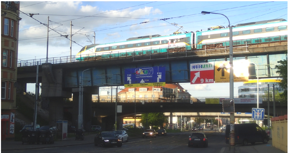
Obrázek 22: Mostní estakády v oblasti Balabenky. Niveleta tratě je zde cca 16 m nad terénem. V popředí železniční trať 525B s jednotkou ČD 680 Pendolino, v pozadí železniční trať 525F.
