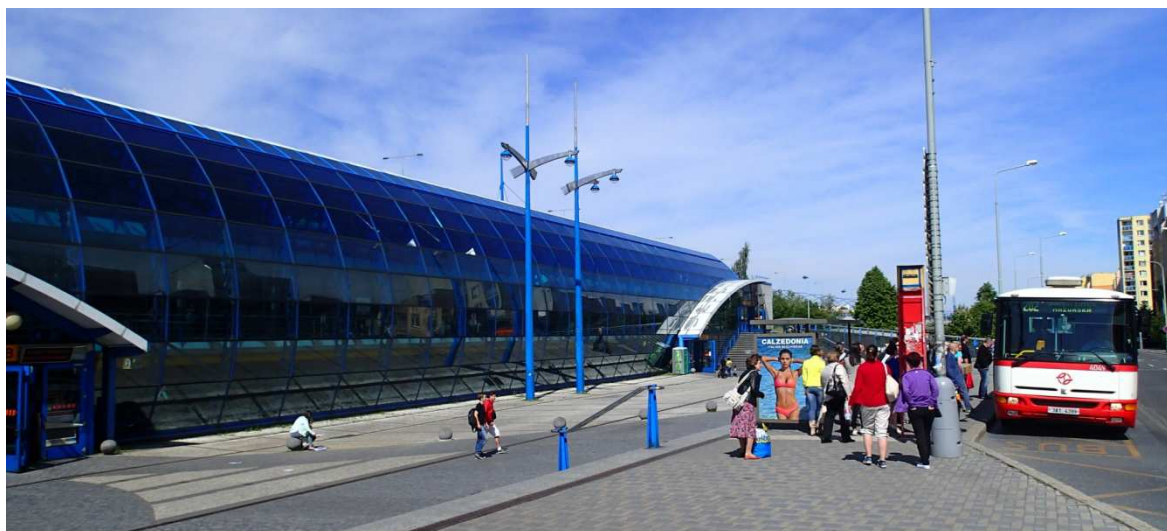
Obrázek 36: Pohled na stanici metra B Rajska zahrada a její osobité architektonické ztvárnění, které již asi bude navždy jiné než přilehlá železniční zastávka. Železniční zastávka má možnost kromě významnějšího přestupu zajistit i oživení celého prostoru formou nových služeb.
