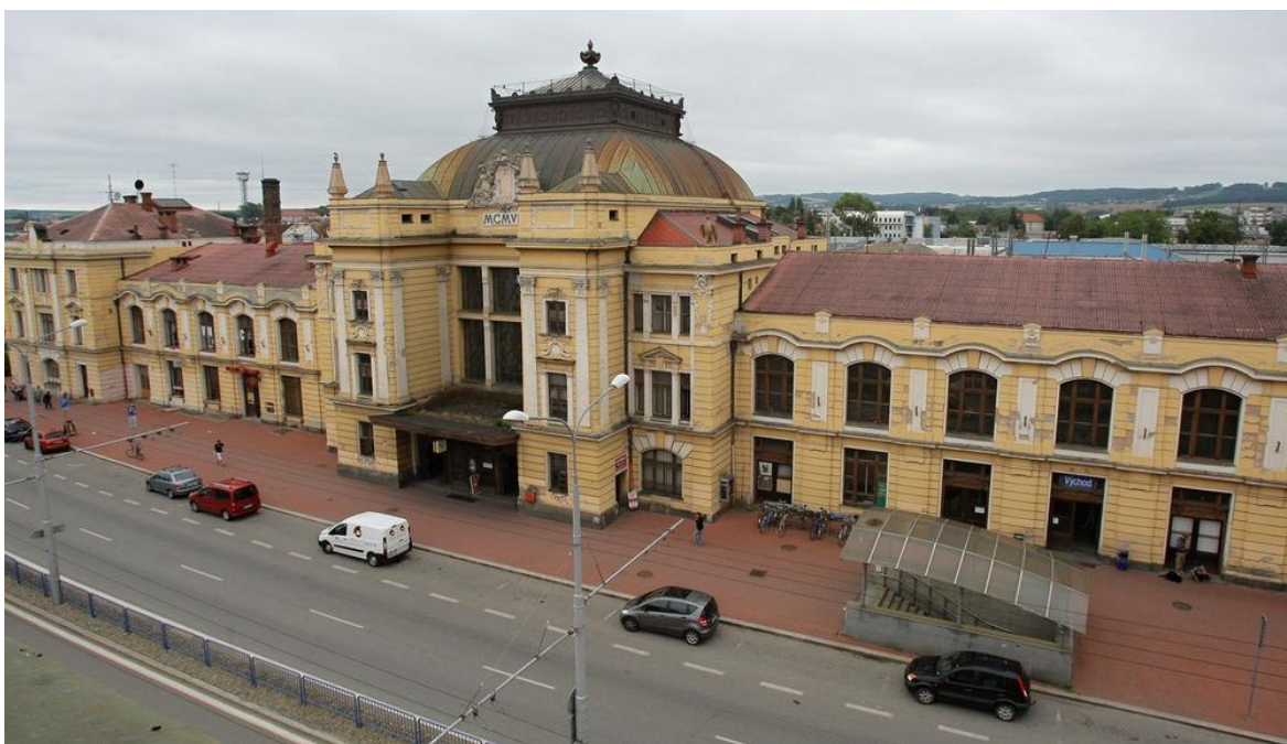
Obrázek 16 - Výpravní budova žst. České Budějovice
