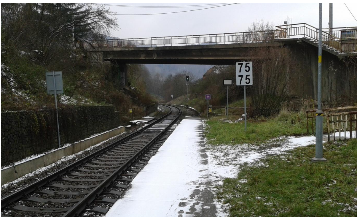
Obrázek 16 Pohled na silniční nadjezd u zastávky Malá Veleň
