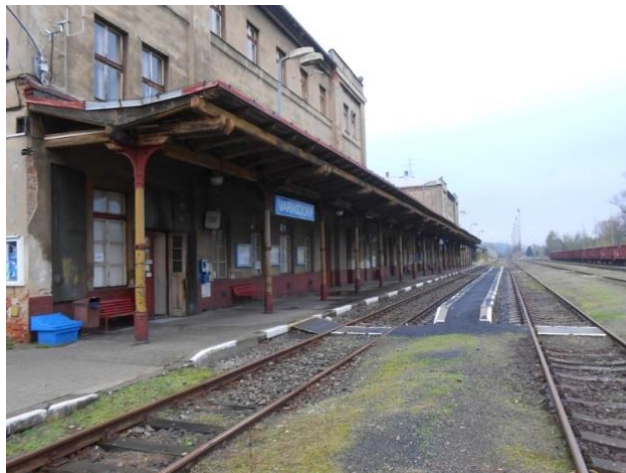
28 I. a II. nástupiště konstrukce TISCHER
