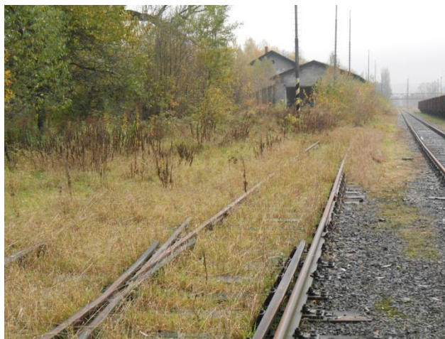
30 Příklad zbytné infrastruktury manipulační kolej č. 8 spolu s výhybkou č. 20
