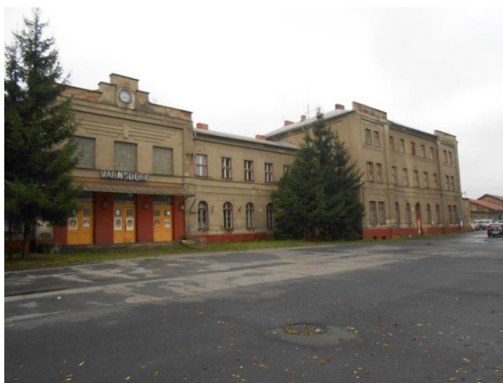
29 Výpravní budova ŽST Varnsdorf
