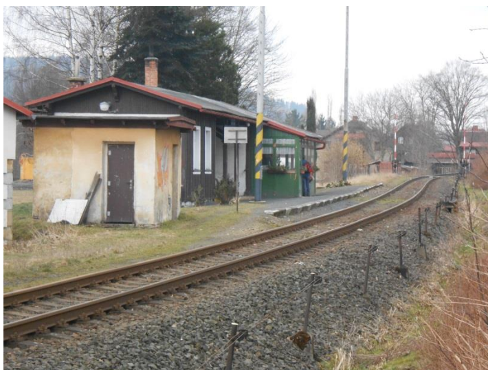
26 Zastávka Horní Podluží s nástupištěm s výškou 20mm nad TK
