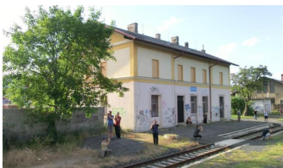
Obr. 9 Železniční stanice Jirkov
