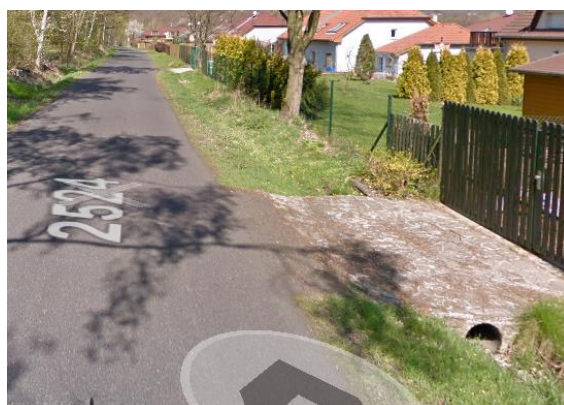
Obr. 21 Postranní odvodňovací rigol a vjezd s propustkem
