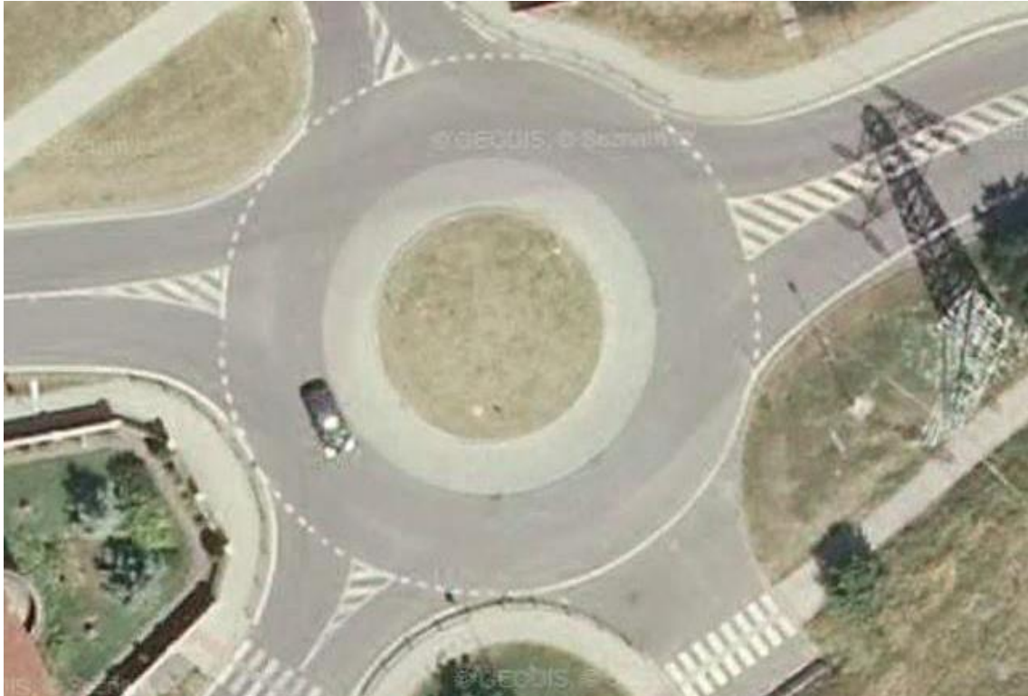
Obr. 9 Okružní křižovatka v ulici Postoloprtská (zdroj: [9])
