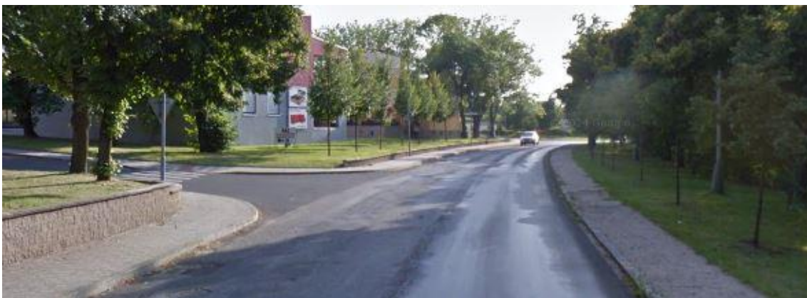
Obr. 15 Ulice 28. října – chybějící vodorovné dopravní značení (zdroj: Autor)
