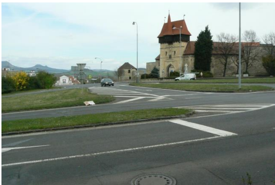
Obr. 22 Pohled na připojení vedlejší komunikace (zdroj: Autor)
