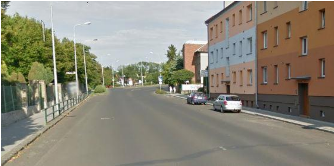
Obr. 14 Ulice 28. října – chybějící vodorovné dopravní značení (zdroj: Autor)
