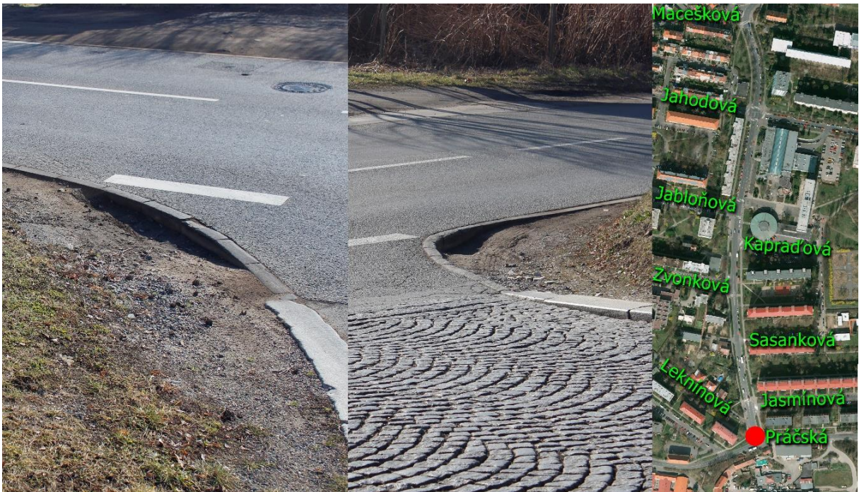
Obrázek 12 Výmoly v křižovatce Topolová x Práčská (zdroj: Autor, [21])
