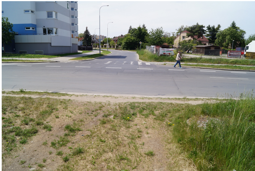
Obrázek 11.1: Křižovatka Na Křečku x Hornoměřolupská v místě budoucího napojení obchodního centra
