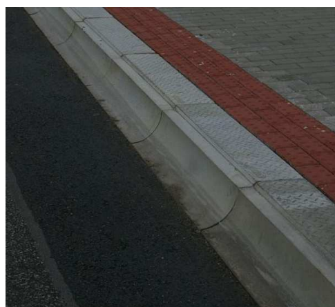
Obr. 12 Zastávkový bezbariérový obrubník [12]
