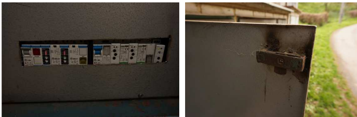
Obrázek 68 – Jističe a poškozená západka rozvodného místa
