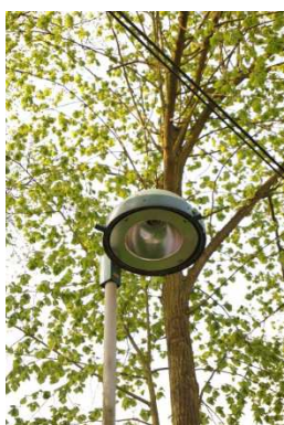
Obrázek 76 – Chybějící difuzor
