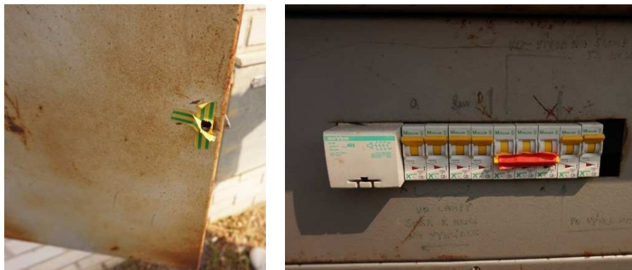
Obrázek 72 – Poškozená dvířka a jističe rozvodného místa
