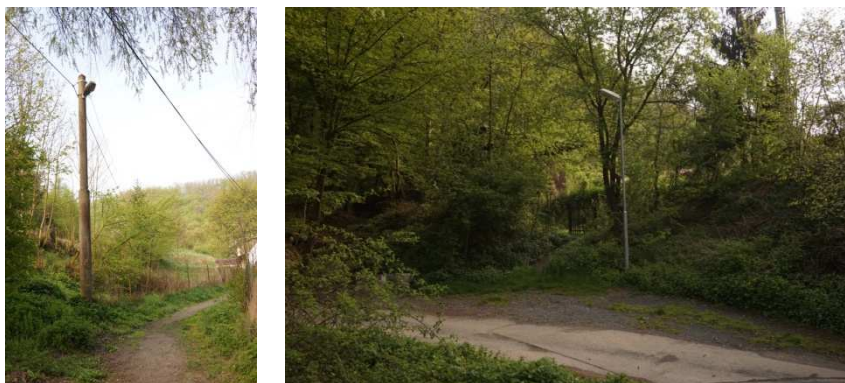
Obrázek 77 – Nevhodně umístěné svítidlo
