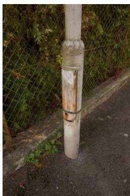
Obrázek 79 – Poškozený stožár svítidla
