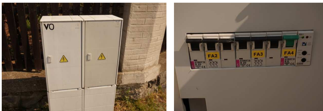
Obrázek 69 – Rozvodné místo a jističe rozvodného místa
