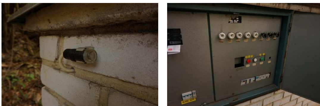
Obrázek 67 – Fotočidlo a jističe rozvodného místa
