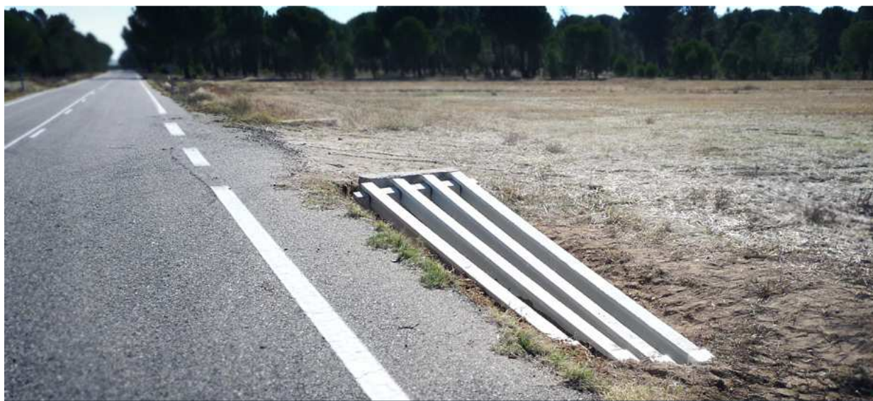
Obrázek 31 - Zešikmené čelo tuhého propustku CROSSAFE pod sjezdem [7]
