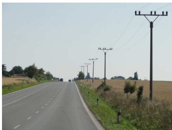
Obrázek 37 - Betonové sloupy el. vedení tvořící pevnou překážku
