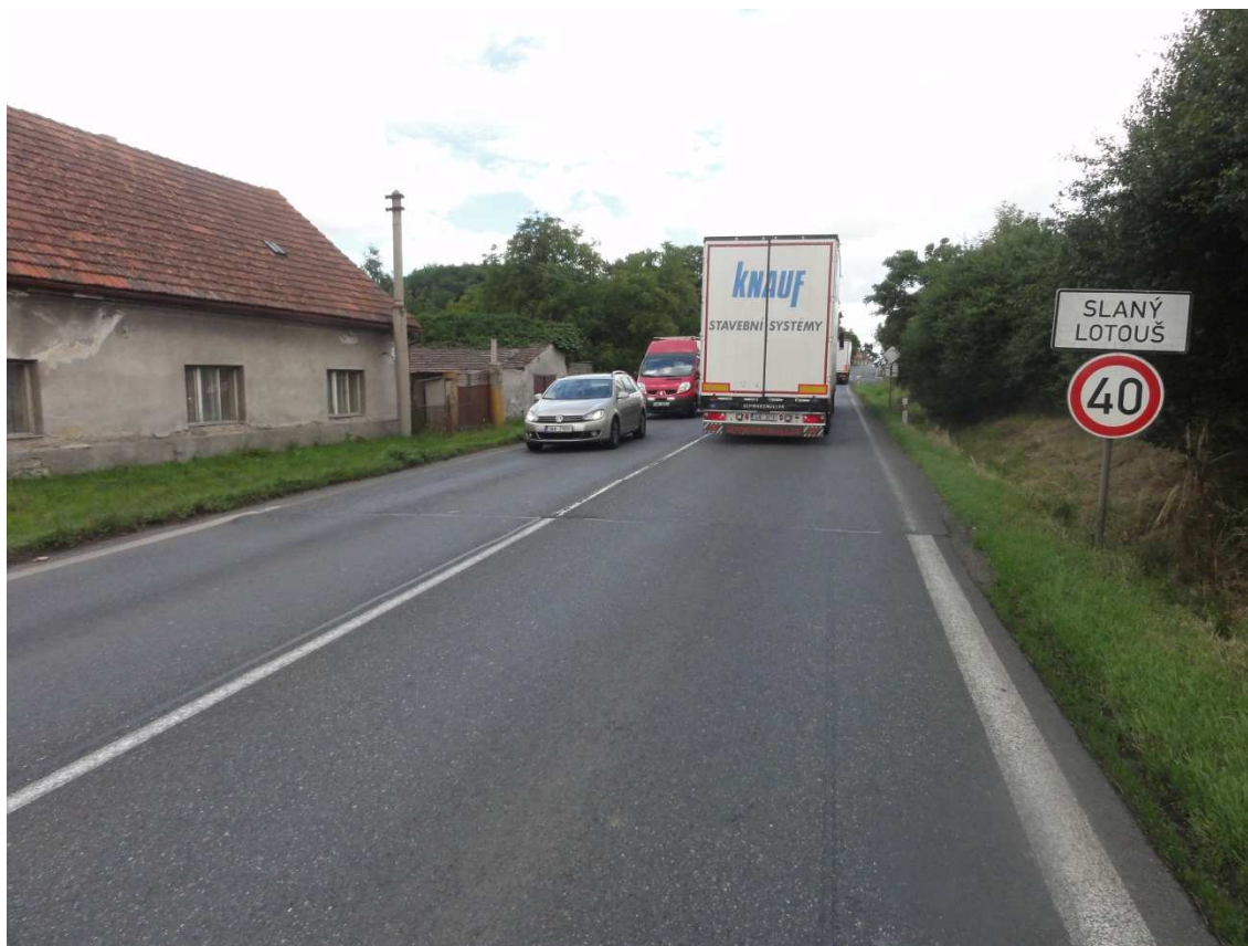
Obrázek 26 - Nevhodně provedený vjezd do obce (závada č. 7 – P – 53)
