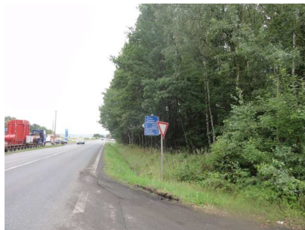
Obrázek 36 - Stromořadí tvořící pevnou překážku
