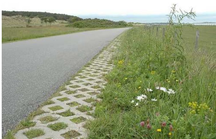
Obrázek 61 - Zpevněná krajnice pomocí betonové zatravňovací dlažby
