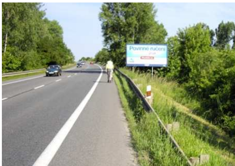
Obrázek 52 - Reklamní zařízení ochráněno svodidly
