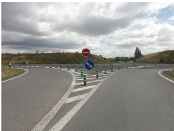
Obrázek 39 - Kanalizace křižovatky pomocí DZ
