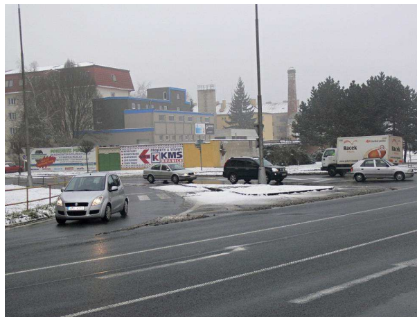
Obrázek 40 - Kanalizace křižovatky pomocí zvýšených směrových ostrůvků
