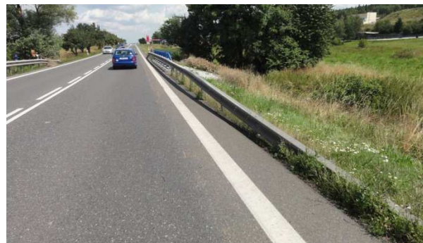
Obrázek 30 - Příčný propustek ochráněný svodidly
