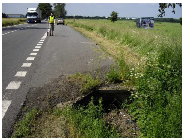
Obrázek 67, 68 - Ilustrativní příklady zanedbaných odvodňovacích příkopů
