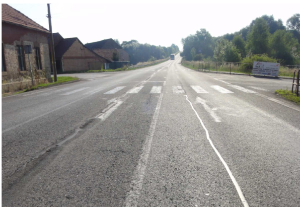
Obrázek 55 - Dlouhý nedělený přechod v křižovatce
