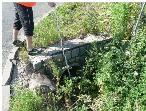
Obrázek 67, 68 - Ilustrativní příklady zanedbaných odvodňovacích příkopů
