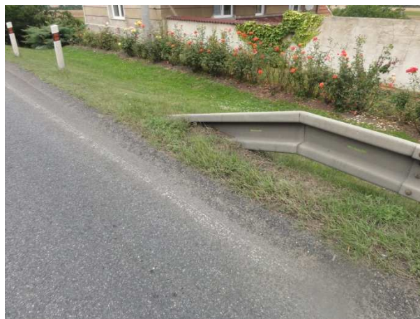
Obrázek 34 - Krátký výškový náběh svodidla
