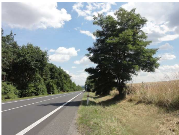
Obrázek 35 - Stromy tvořící pevnou překážku
