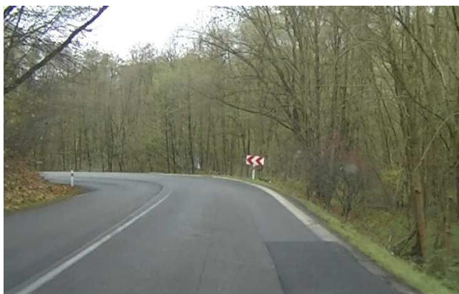
Obrázek 69 - Riziková změna směrového vedení
