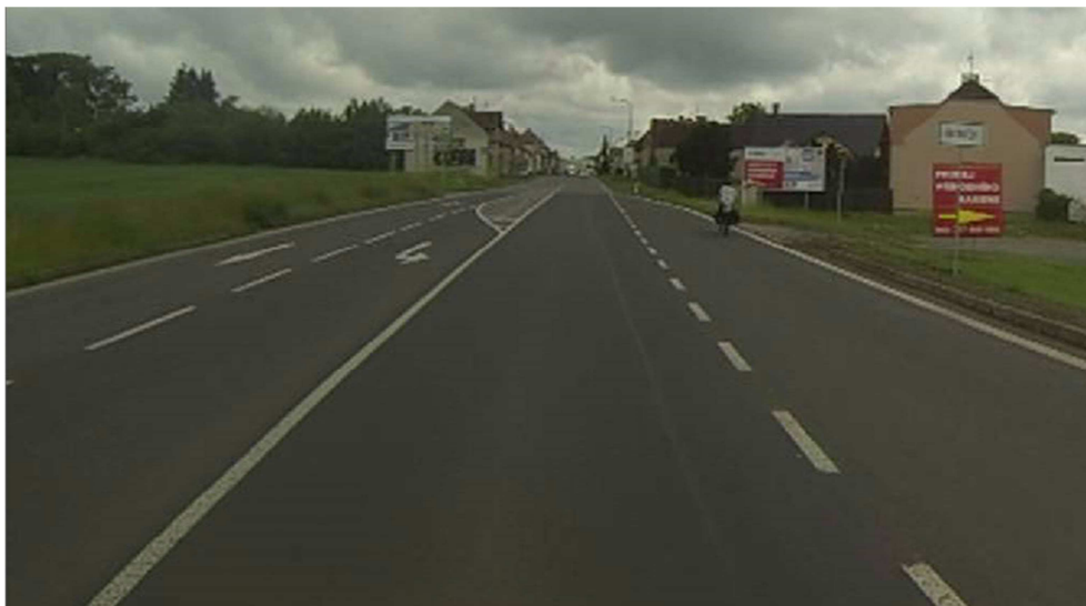
Obrázek 44 - Nevhodný přechod extravilán – intravilán, bez zklidňujících opatření
