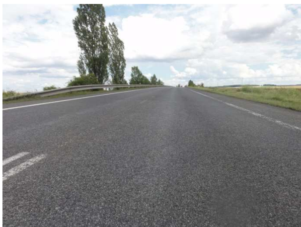
Obrázek 53 - Chybějící VDZ
