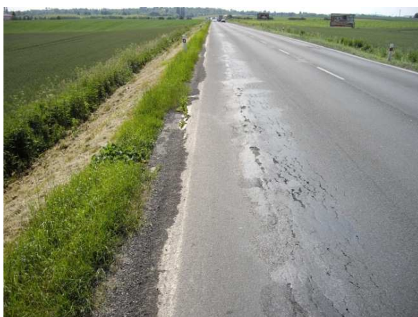
Obrázek 59 - Chybějící krajnice
