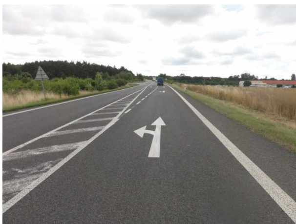
Obrázek 65 - Použití VDZ 9a „Směrové šipky“ na hlavní pozemní komunikaci
