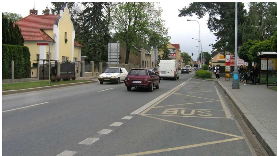
Obrázek 43 - Správně provedená nástupní hrana autobusové zastávky
