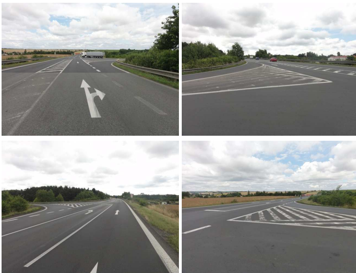
Obrázek 21, 22, 23 a 24 – Nevhodně řešená křižovatka (závada č. 7 – P – 24)
