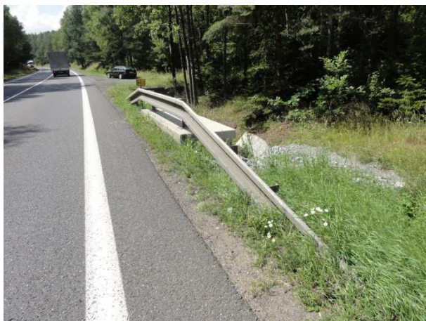
Obrázek 33 - Krátké svodidlo s krátkými výškovými náběhy
