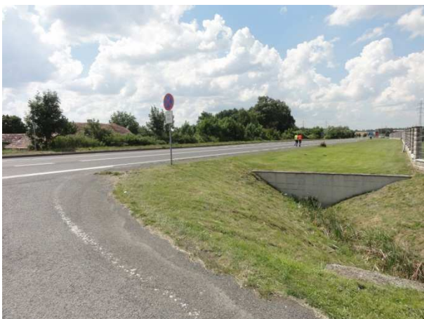
Obrázek 27 - Tuhé čelo podélného propustku
