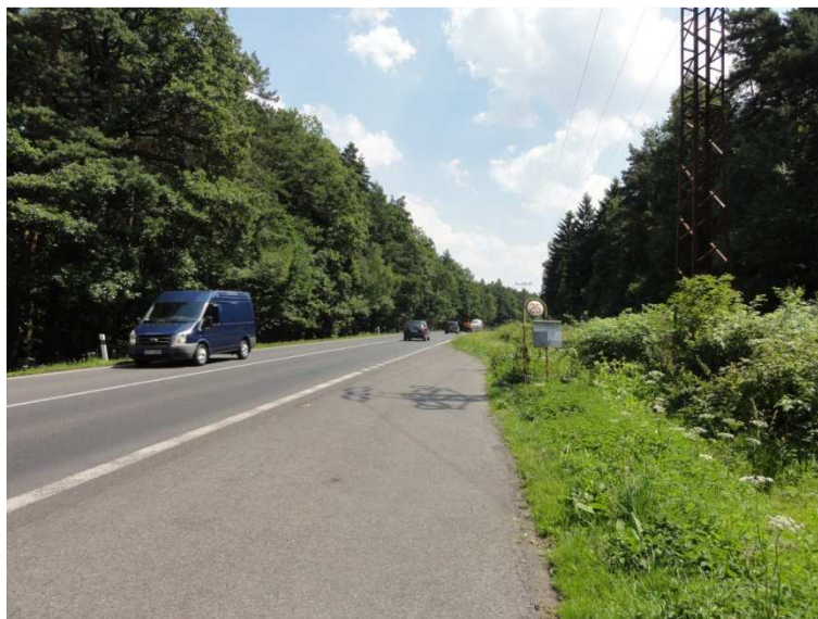
Obrázek 41 - Nevhodné řešení autobusové zastávky
