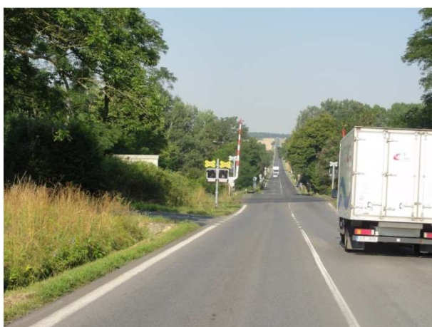
Obrázek 63 - Špatná postřehnutelnost křižovatky
