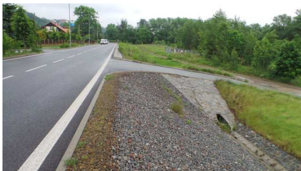
Obrázek 29 - Zešikmené čelo tuhého propustku pod připojovanou komunikací
