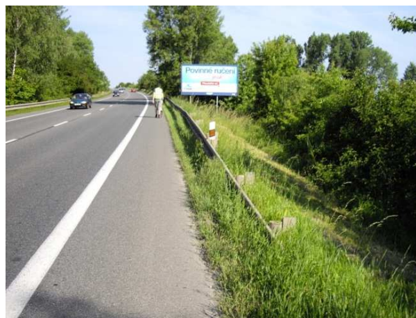
Obrázek 60 - Široká asfaltová krajnice
