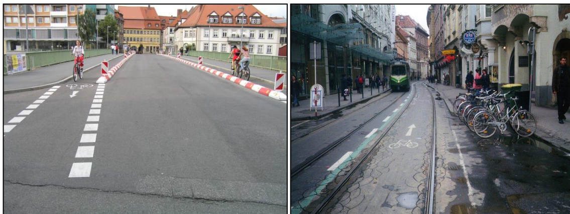
Obr. 19 a 20 – Vlevo: Nestavební fyzické oddělení jízdních pruhů pro cyklisty ve městě Bamberg (zdroj: EDIP s.r.o), vpravo: Vyznačení průjezdu pro cyklisty uprostřed tramvajového pásu v rakouském městě Graz (zdroj: Jiří Čarský)
