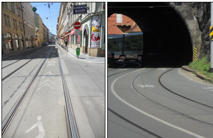
Obr. 23 a 24 – Vyznačení průjezdu pro cyklisty uprostřed tramvajového pásu v ul. Lidická (vlevo) a ve Vyšehradském tunelu (vpravo)
