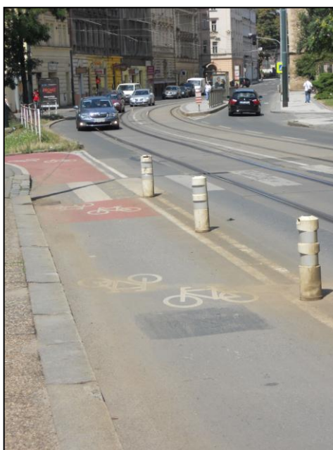
Obr. 26 – Oddělení prostoru pro cyklisty v rámci HDP pomocí (bílých) baliset v ul. Na Slupi
