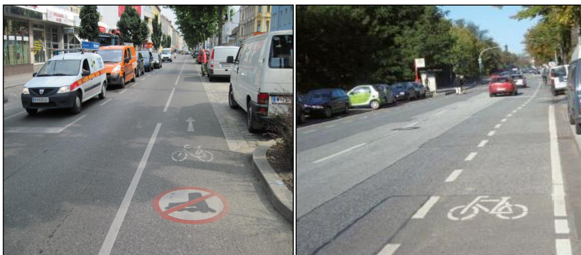
Obr. 11 a 12 – Vlevo: doporučený cyklopruh (cykloobousměrka) ve Vídni s vyznačením zákazu vstupu bruslařům (zdroj: Pavel Skládaný), vpravo: doporučený cyklopruh v Hamburku (zdroj: 40 lekcí cyklodopravy pro odborníky)
