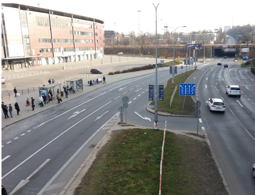
Obrázek. 25 Stávající zastávka Slavia ve směru Bělocerkevská
